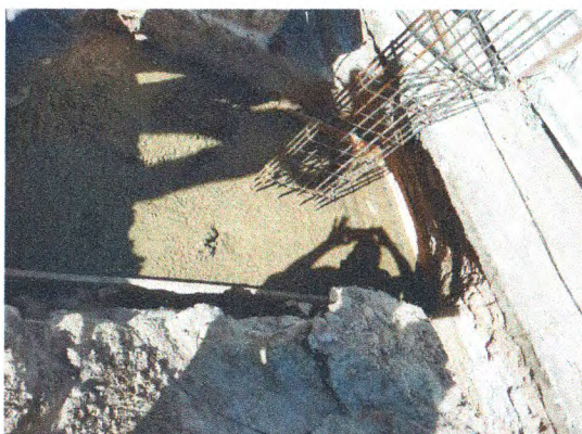
CONCRETAGEM DAS SAPATAS
