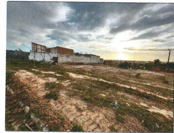
LIMPEZA DO TERRENO
