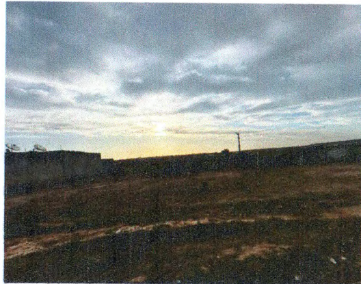
LIMPEZA DO TERRENO
