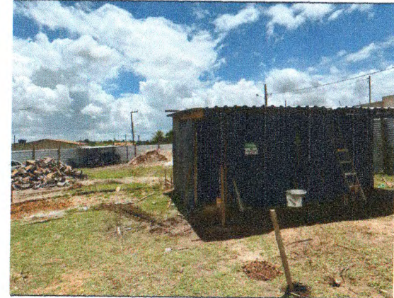
BARRACÃO E TAPUME
