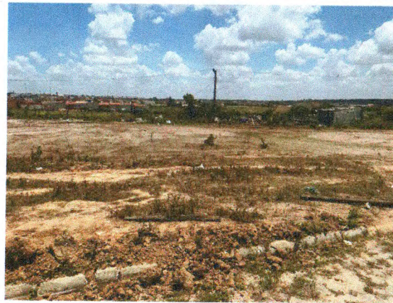
LIMPEZA DO TERRENO
