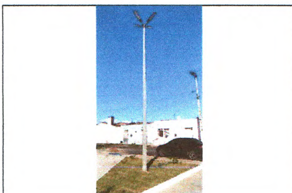
Engastamento de postes de concreto
