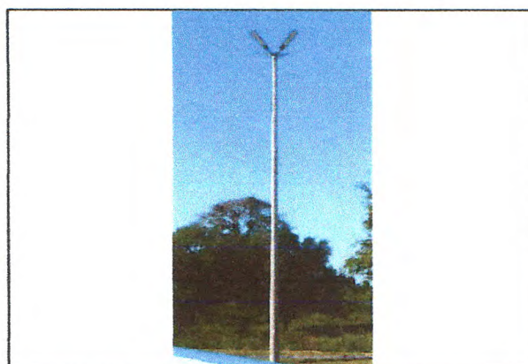
Engastamento de postes de concreto
