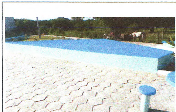
Pintura acrílica em piso cimentado
