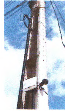
Relé fotoelétrico para comando de iluminação externa
