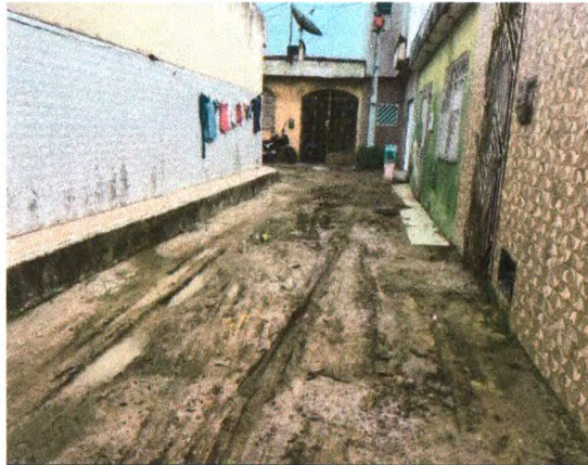
REGULAZIÇÃO E COMPACTAÇÃO DO SOLO NA RUA EGILDO SANTOS
