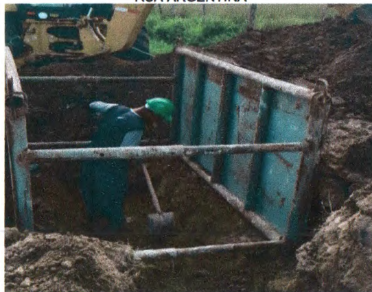
ESCAVAÇÃO E ESCORAMENTO METÁLICO NA TRAVESSA IVAN ANDRADE
