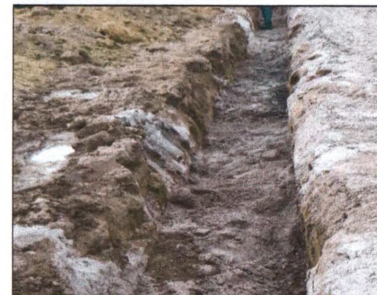
ESCAVAÇÃO NA RUA PEDRO BARBOSA DE JESUS
