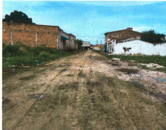
REGULARIZAÇÃO E COMPACTAÇÃO DO SOLO NA RUA PROJETADA
