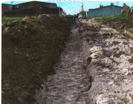
ESCAVAÇÃO NA RUA JOSÉ BRAZ DOS SANTOS
