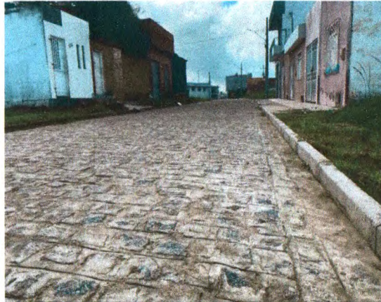
ASSENTAMENTO DE MEIO-FIO E PAVIMENTAÇÃO NA RUA ARGENTINA
