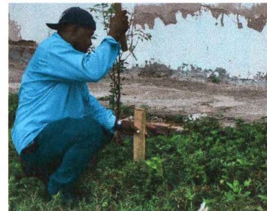
LOCAÇÃO DA PAVIMENTAÇÃO
