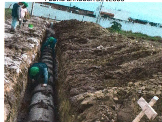
ASSENTAMENTO DA TUBULAÇÃO NA RUA JOSÉ BRAZ DOS SANTOS
