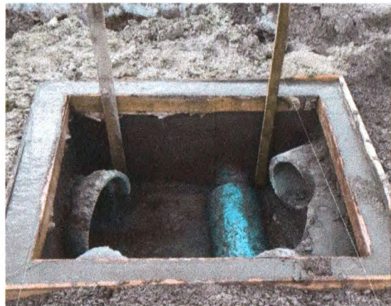
ASSENTAMENTO DA CAIXA DE PASSAGEM NA RUA JOSÉ BRAZ DOS SANTOS
