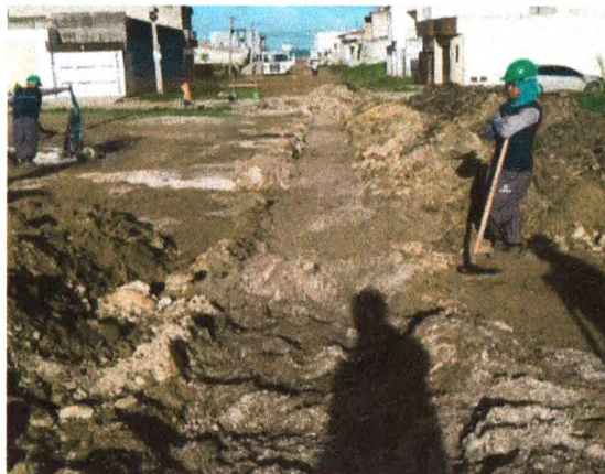
ESCAVAÇÃO NA RUA PEDRO BARBOSA DE JESUS
