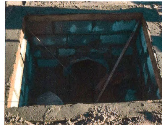
ASSENTAMENTO DE CAIXA DE PASSAGEM NA RUA PEDRO BARBOSA DE JESUS
