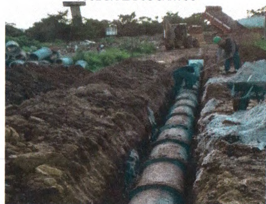
ASSENTAMENTO DA TUBULAÇÃO NA RUA PEDRO BARBOSA DE JESUS
