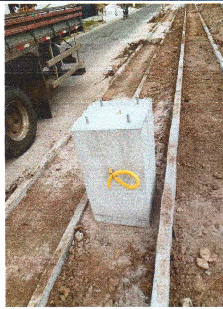
Bloco de concreto para fixação de poste de aço
