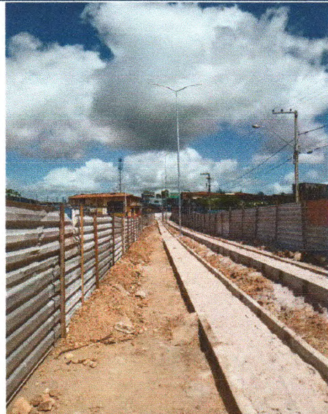
Poste de aço com luminária
