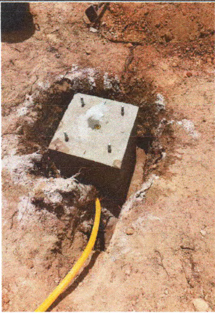
Bloco de concreto para fixação de poste de aço
