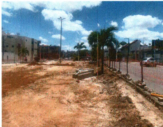
DEMOLIÇÃO E ESCAVAÇÃO
