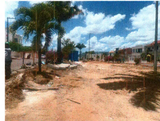
DEMOLIÇÃO E ESCAVAÇÃO
