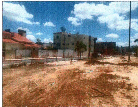
DEMOLIÇÃO E ESCAVAÇÃO
