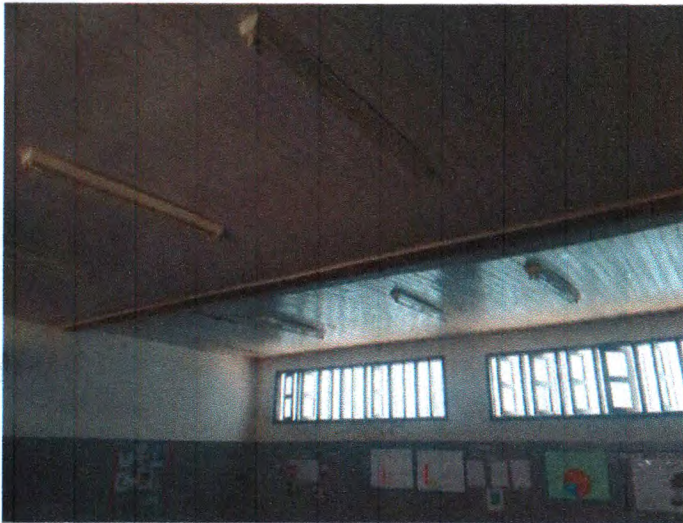
Remoção de forros de pvc, de forma manual, sem reaproveitamento
