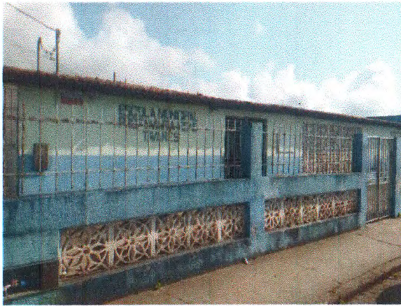
LOCAL DA MANUTENÇÃO
