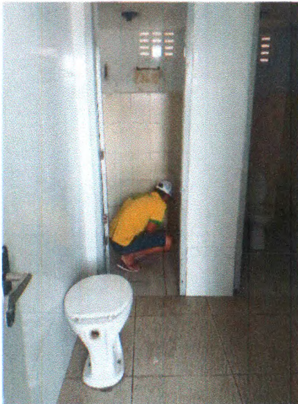
Remoção Vaso sanitário
