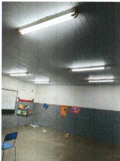
Forro de pvc, em régulas, aplicado
