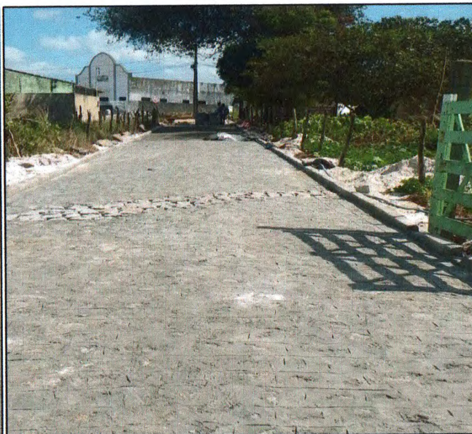
Foto 08: Pavimentação em paralelepípedo granítico sobre colchão de areia.
