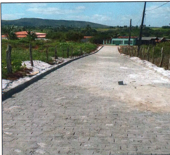
Foto 07: Pavimentação em paralelepípedo granítico sobre colchão de areia.
