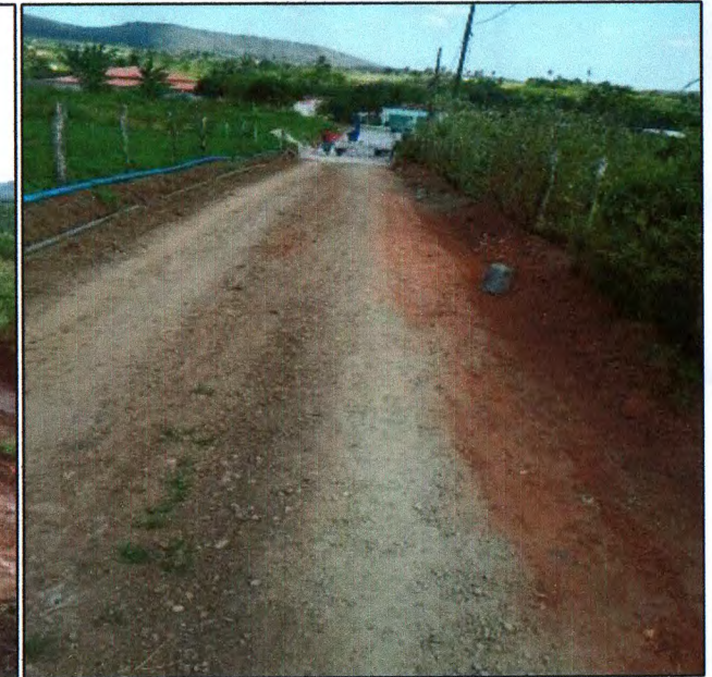
Foto 03: Locação de serviços de pavimentação.
