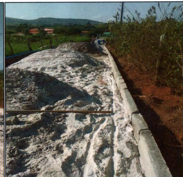
Foto 06: Meio-fio pré-moldado de concreto simples.
