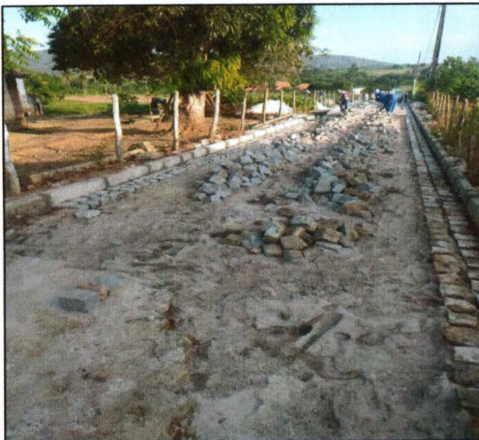
Foto 04: Pavimentação em paralelepípedo granítico sobre colchão de areia.
