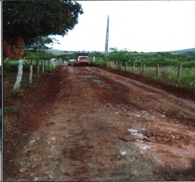
Foto 02: Regularização e compactação de subleito de solo.
