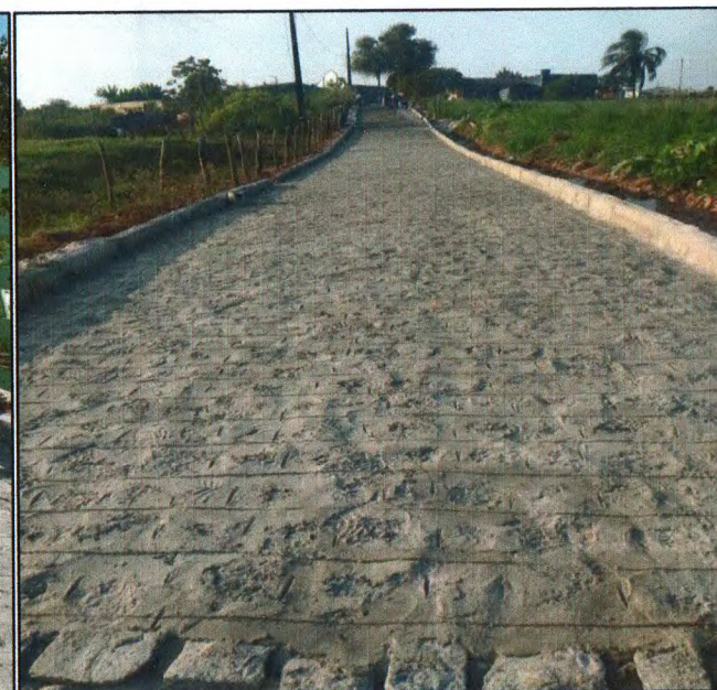
Foto 09: Pavimentação em paralelepípedo granítico sobre colchão de areia.
