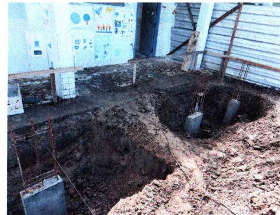
ESCAVAÇÃO; LOCAÇÃO COM GABARITO DE MADEIRA; CONCRETO ARMADO SAPATAS E ARRAQUES DE PILAR
