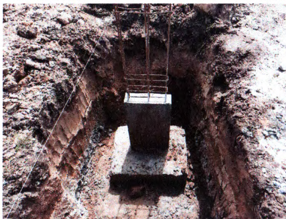
ESCAVAÇÃO; CONCRETO ARMADO SAPATA E ARRAQUE DE PILAR
