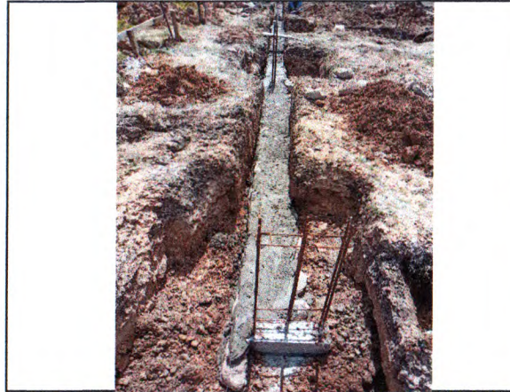
ESCAVAÇÃO; ALVENARIA DE PEDRA ARGAMASSADA; CONCRETO ARMADO
