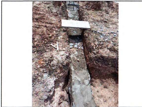
ESCAVAÇÃO; ALVENARIA DE PEDRA ARGAMASSADA; CONCRETO ARMADO
