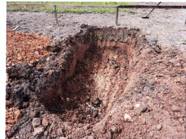
ESCAVAÇÃO; LOCAÇÃO COM GABARITO DE MADEIRA
