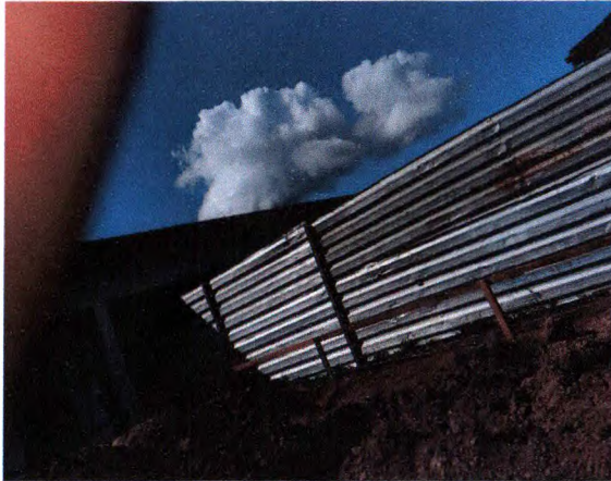
TAPUME EM CHAPA METÁLICA; ESCAVAÇÃO; LOCAÇÃO COM GABARITO DE MADEIRA
