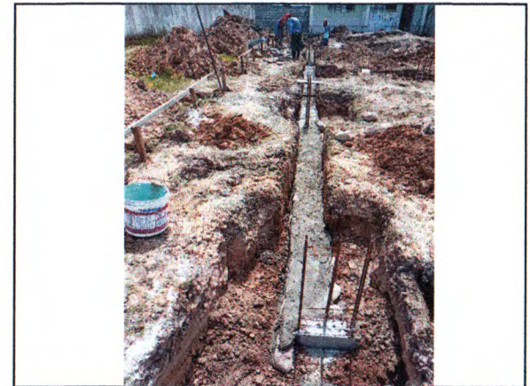
LOCAÇÃO COM GABARITO DE MADEIRA; ESCAVAÇÃO; ALVENARIA DE PEDRA ARGAMASSADA; CONCRETO ARMADO
