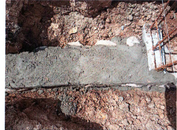
ESCAVAÇÃO; ALVENARIA DE PEDRA ARGAMASSADA; CONCRETO ARMADO
