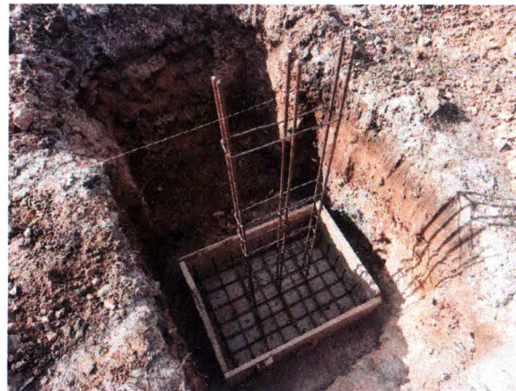
ESCAVAÇÃO; CONCRETO MAGRO; FORMA DE MADEIRA; FERRAGEM SAPATA E ARRAQUE DE PILAR
