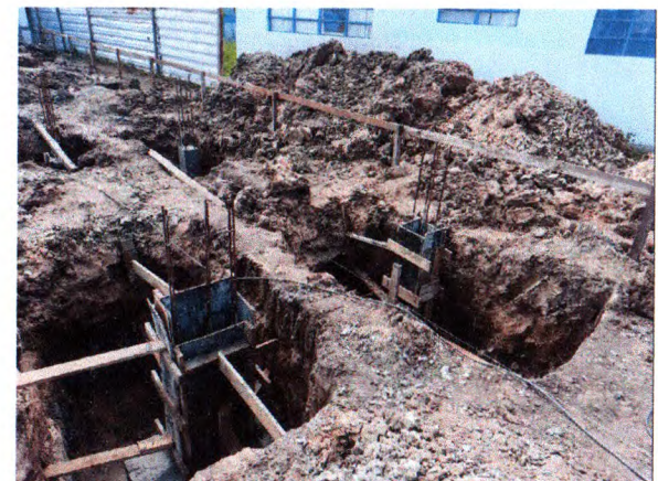
ESCAVAÇÃO; LOCAÇÃO COM GABARITO DE MADEIRA; CONCRETO MAGRO; FORMA DE MADEIRA; FERRAGEM SAPATA E ARRAQUE DE PILAR
