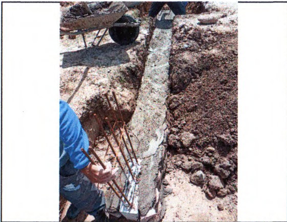
ESCAVAÇÃO; ALVENARIA DE PEDRA ARGAMASSADA; CONCRETO ARMADO
