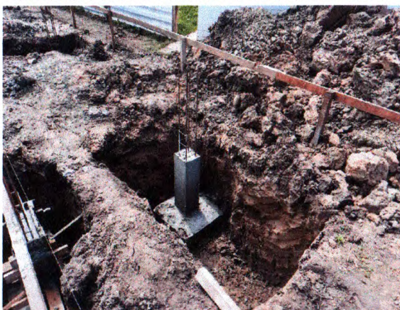
ESCAVAÇÃO; LOCAÇÃO COM GABARITO DE MADEIRA; CONCRETO ARMADO SAPATA E ARRAQUE DE PILAR
