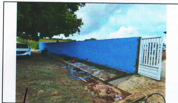
Piso em concreto, pintura e porta em alumínio
