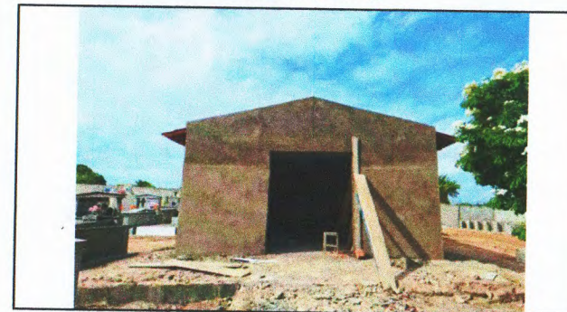
Emassamento e pintura
