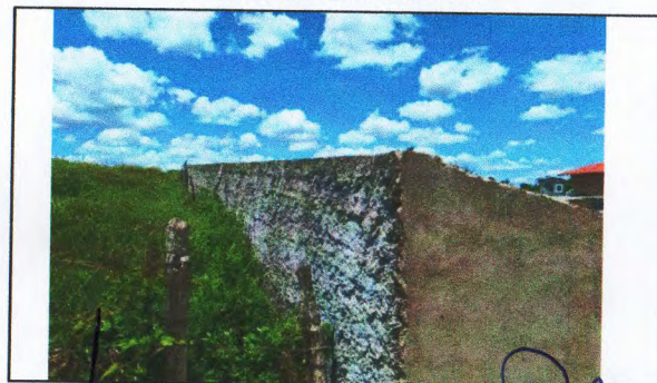
Chapisco de parede e reboco
