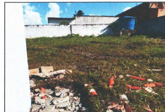
DEMOLIÇÕES E SERVIÇOS PRELIMINARES
