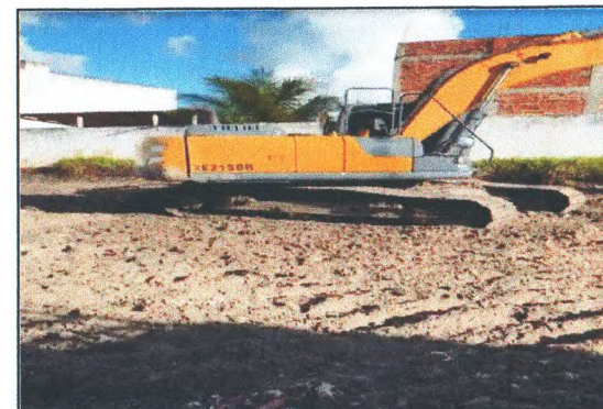
DEMOLIÇÕES E SERVIÇOS PRELIMINARES
