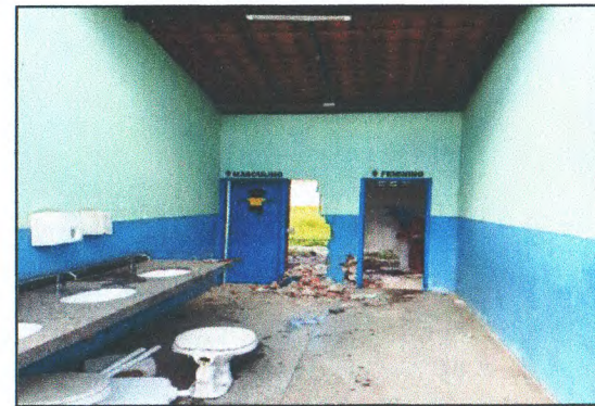
DEMOLIÇÕES E SERVIÇOS PRELIMINARES
