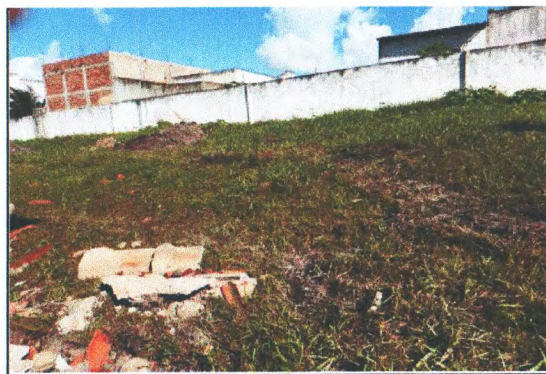
DEMOLIÇÕES E SERVIÇOS PRELIMINARES
