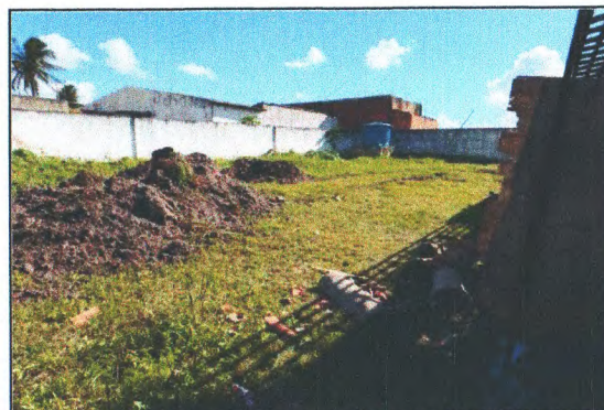
DEMOLIÇÕES E SERVIÇOS PRELIMINARES
