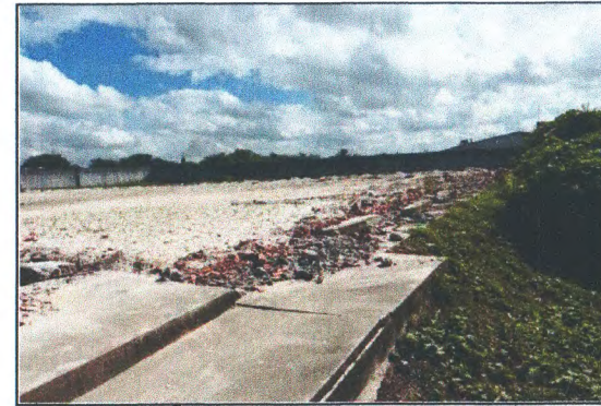
DEMOLIÇÕES E SERVIÇOS PRELIMINARES
