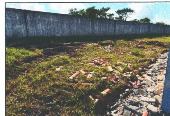
DEMOLIÇÕES E SERVIÇOS PRELIMINARES
