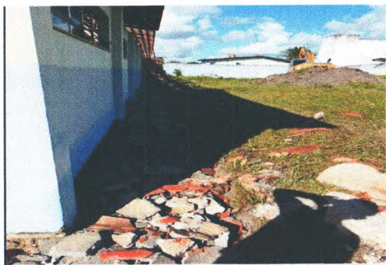
DEMOLIÇÕES E SERVIÇOS PRELIMINARES
