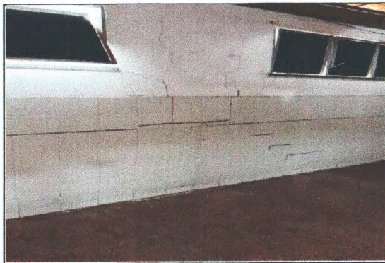
DEMOLIÇÕES E SERVIÇOS PRELIMINARES
