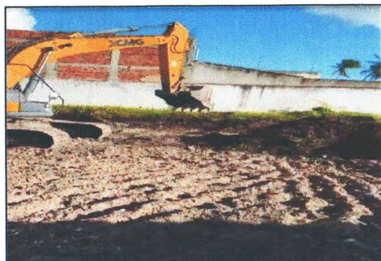
DEMOLIÇÕES E SERVIÇOS PRELIMINARES
