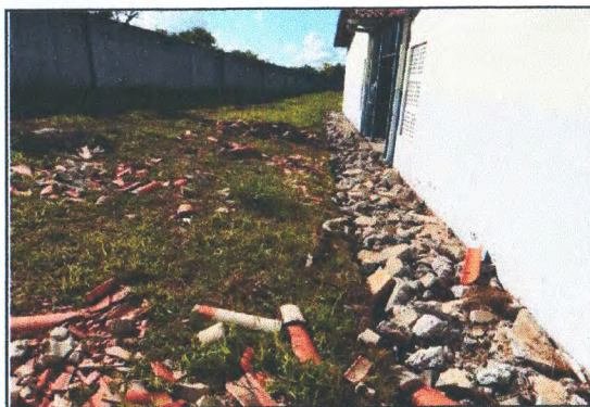
DEMOLIÇÕES E SERVIÇOS PRELIMINARES
