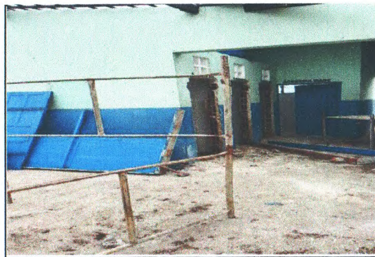
DEMOLIÇÕES E SERVIÇOS PRELIMINARES
