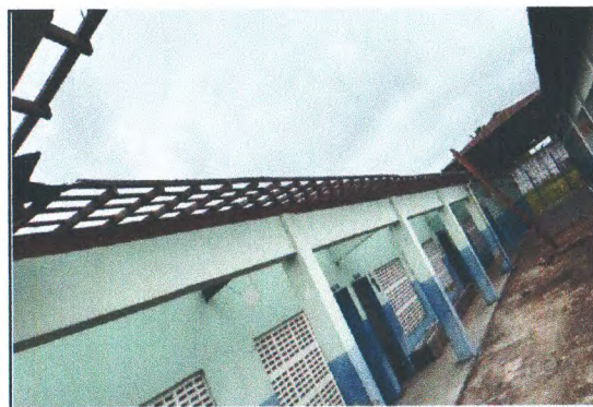
DEMOLIÇÕES E SERVIÇOS PRELIMINARES
