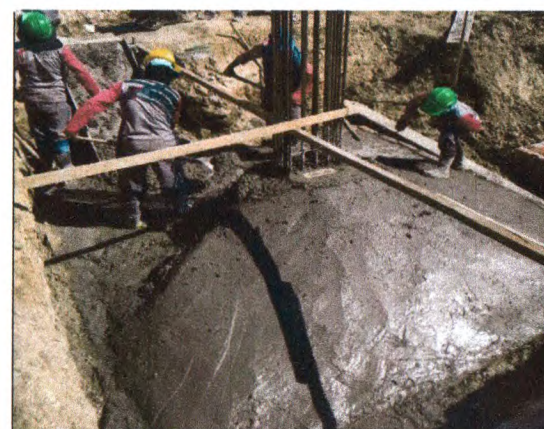
EXECUÇÃO DA SAPATA: LANÇAMENTO DO CONCRETO
