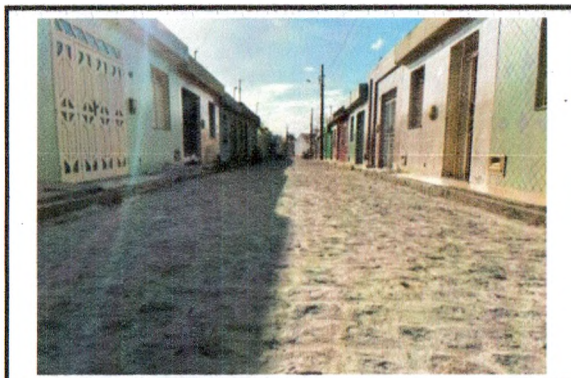
PAVIMENTAÇÃO - TRAVESSA PROJETADA
