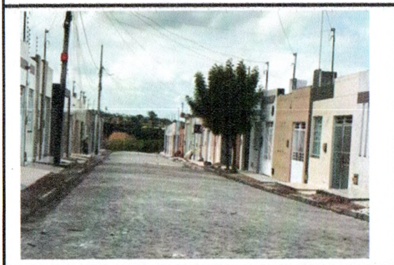
PAVIMENTAÇÃO - PROLONGAMENTO DA RUA MONSENHOR CONSTANTINO
