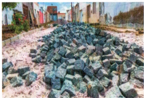
PAVIMENTAÇÃO E ASSENTAMENTO DE MEIO FIO - TRAVESSA PROJETADA
