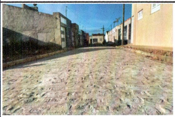
PAVIMENTAÇÃO - TRAVESSA PROJETADA 04
