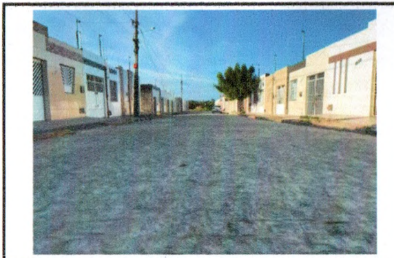
PAVIMENTAÇÃO - PROLONGAMENTO DA RUA MONSENHOR CONSTANTINO
