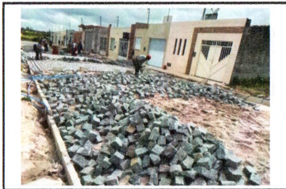
ASSENTAMENTO DE MEIO-FIO, COLCHÃO DE AREIA E PAVIMENTAÇÃO - PROLONGAMENTO DA RUA MONSENHOR CONSTANTINO
