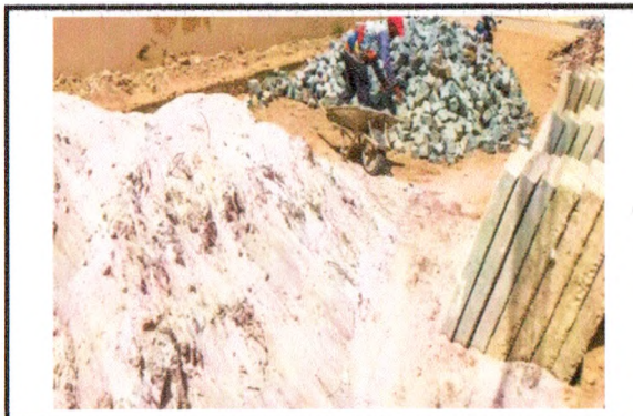
COLCHÃO DE AREIA, ASSENTAMENTO DE MEIO FIO E PAVIMENTAÇÃO - MAURINO JOSÉ DA SILVA
