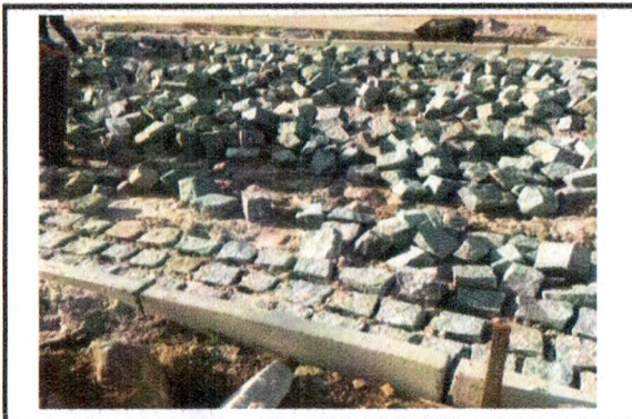
ASSENTAMENTO DE MEIO-FIO, DRENAGEM SUPERFICIAL E PAVIMENTAÇÃO - TRAVESSA PROJETA 04
