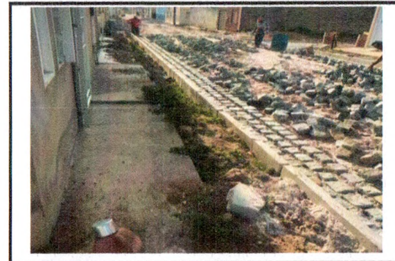
ASSENTAMENTO DE MEIO-FIO, DRENAGEM SUPERFICIAL E PAVIMENTAÇÃO - MAURINO JOSÉ DA SILVA
