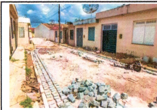
DRENAGEM SUPERFICIAL, COLCHÃO DE AREIA, ASSENTAMENTO DE MEIO FIO E PAVIMENTAÇÃO - TRAVESSA PROJETADA
