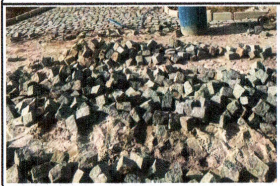
COLCHÃO DE AREIA E PAVIMENTAÇÃO - MAURINO JOSÉ DA SILVA
