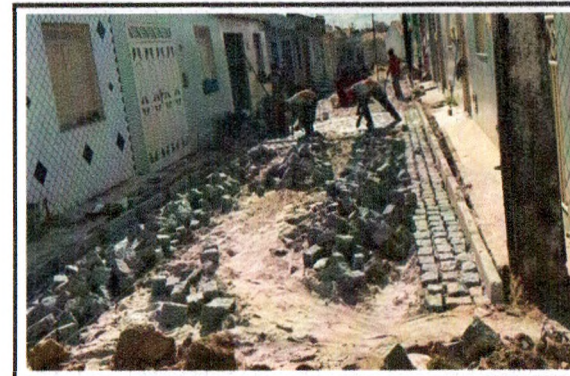
DRENAGEM SUPERFICIAL, COLCHÃO DE AREIA, ASSENTAMENTO DE MEIO FIO E PAVIMENTAÇÃO - TRAVESSA PROJETADA
