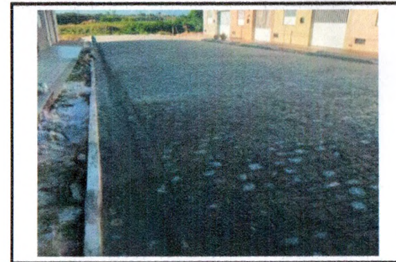
ASSENTAMENTO DE MEIO-FIO, DRENAGEM SUPERFICIAL E PAVIMENTAÇÃO - PROLONGAMENTO DA RUA MONSENHOR CONSTANTINO
