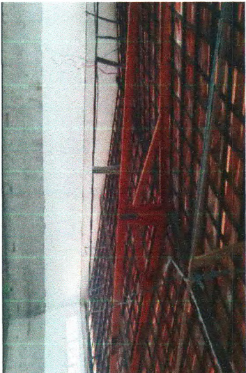
ALVENARIA DE BLOCO CERÂMICO
