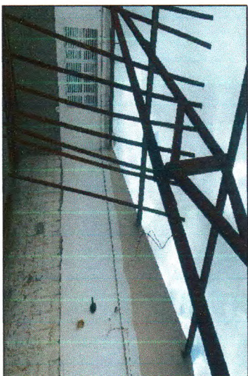
REMOÇÃO DE TESOURAS
