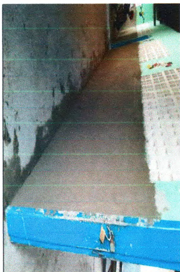
RESTAURO DE REBOCO
