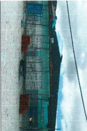
ALVENARIA DE BLOCO CERÂMICO
