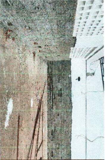
DEMOLIÇÃO DE REVESTIMENTO
