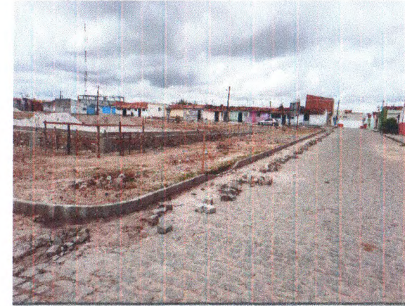
ASSENTAMENTO DE MEIO FIO
