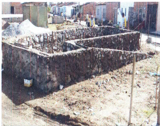
ALVENARIA DE PEDRA ARGAMASSADA
