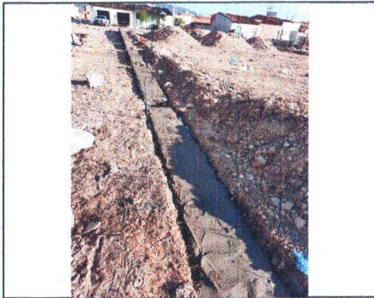
ALVENARIA DE PEDRA ARGAMASSADA
