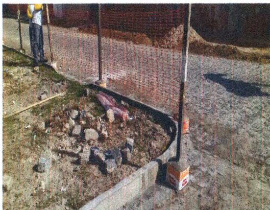
ASSENTAMENTO DE MEIO FIO; TELA POLIETILENO
