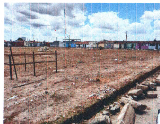
LIMPEZA DO TERRENO; DEMOLIÇÃO DE MEIO FIO; LOCAÇÃO
