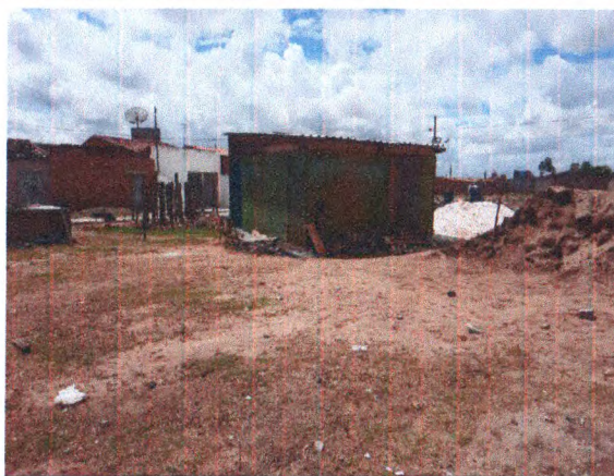
LIMPEZA DO TERRENO; BARRACÃO DA OBRA
