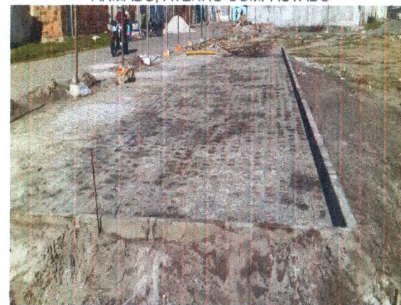
ASSENTAMENTO DE MEIO FIO; PAVIMENTAÇÃO EM PARALELEPÍPEDO
