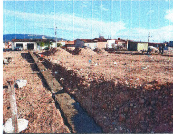
ALVENARIA DE PEDRA ARGAMASSADA
