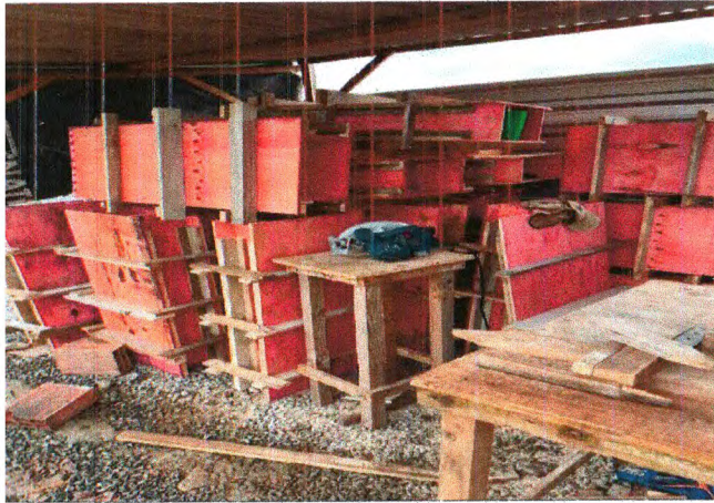
FÔRMA DOS ARRANQUES
