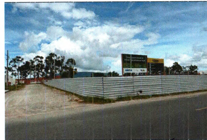
FECHAMENTO DE OBRA
