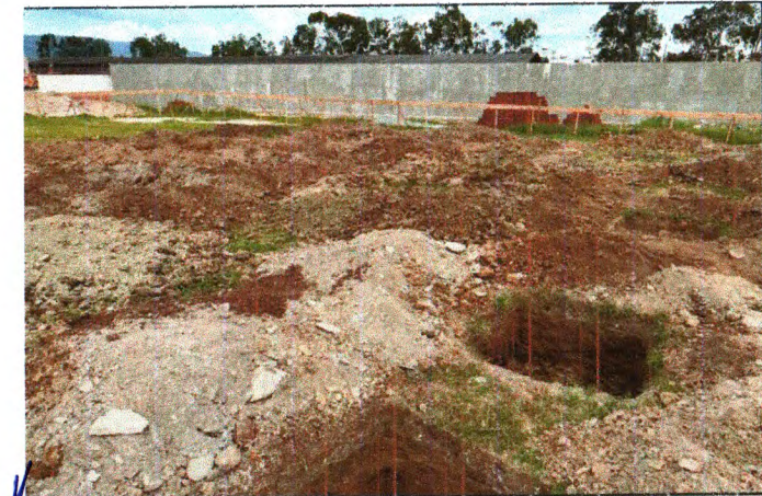
ESCAVAÇÃO DAS SAPATAS
