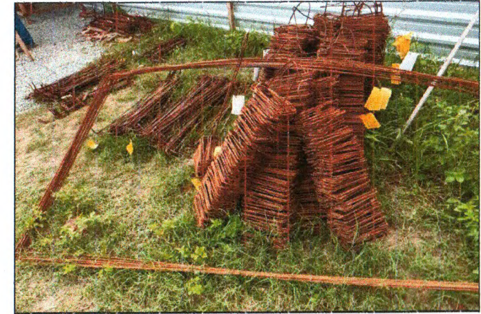
AÇO PARA FUNDAÇÃO CORTADO E DOBRADO
