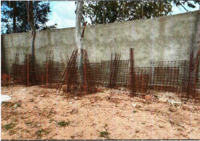
ARMADURA DAS SAPATAS E DOS ARRANQUES
