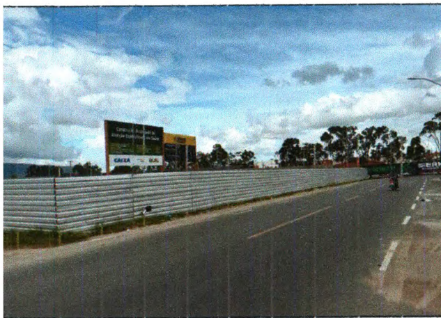
FECHAMENTO DE OBRA
