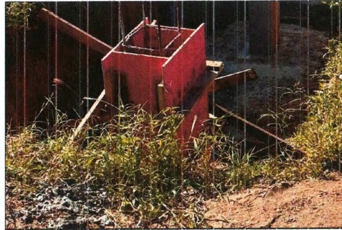
FÔRMA DOS ARRANQUES E CONCRETAGEM
