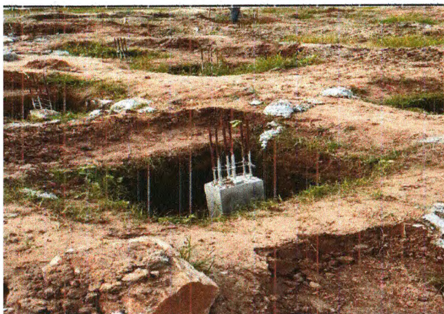
CONCRETAGEM DOS ARRANQUES
