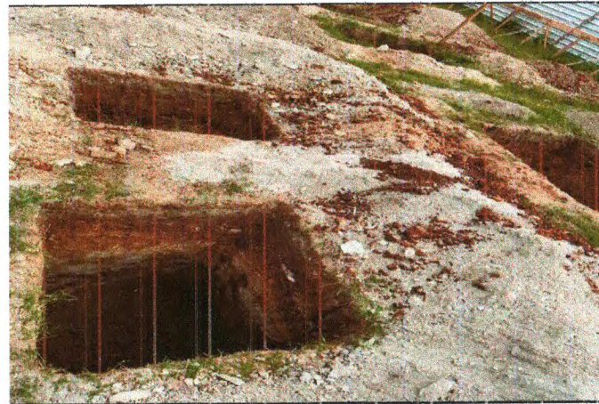
ESCAVAÇÃO DAS SAPATAS
