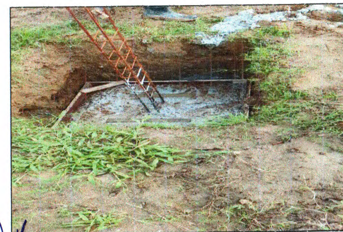
FÓRMA E CONCRETO DAS SAPATAS José Robinson Sales da Paiva Eng. Civil - CREA 27202939-4 Coordenador de Núcleo Prefeitura Municipal de Itabaiana
