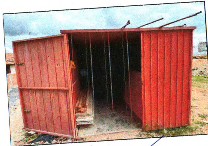
BARRACÃO FECHADO PARA DEPÓSITO
