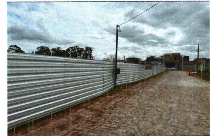
FECHAMENTO DE OBRA
