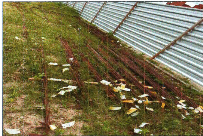
AÇO PARA FUNDAÇÃO CORTADO E DOBRADO
