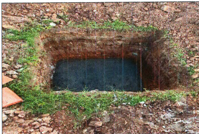
LASTRO DE CONCRETO MAGRO
