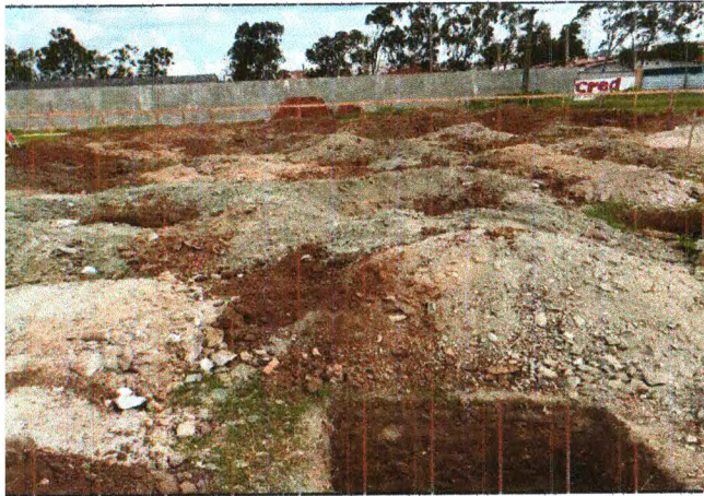
ESCAVAÇÃO DAS SAPATAS
