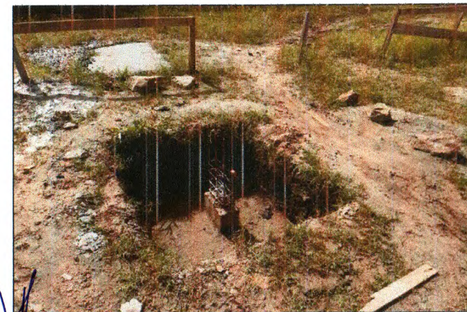
ARRANQUES CONCRETADOS E SAPATAS EM ATERRAMENTO
