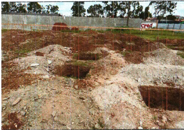
ESCAVAÇÃO DAS SAPATAS
