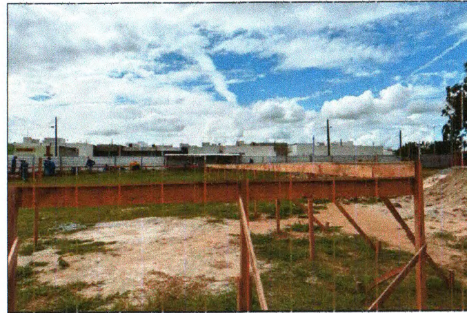
GABARITO DA CONSTRUÇÃO
