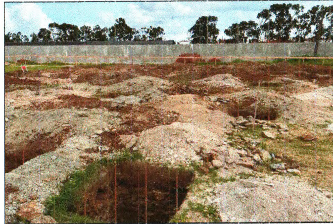
ESCAVAÇÃO DAS SAPATAS
