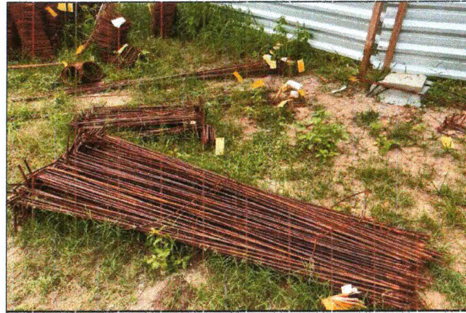
AÇO PARA FUNDAÇÃO CORTADO E DOBRADO
