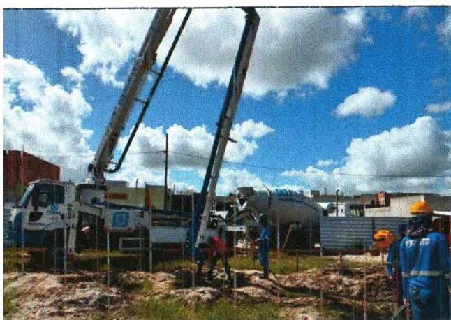
BOMBEAMENTO DO CONCRETO
