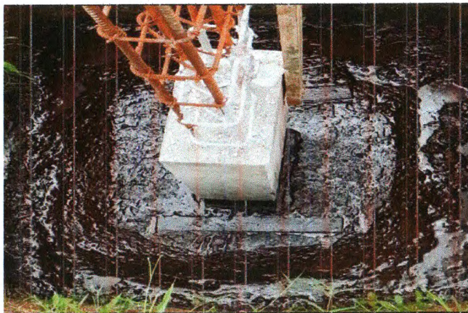
IMPERMEABILIZAÇÃO DAS SAPATAS
