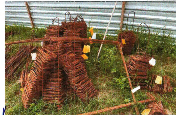
AÇO PARA FUNDAÇÃO CORTADO E DOBRADO
