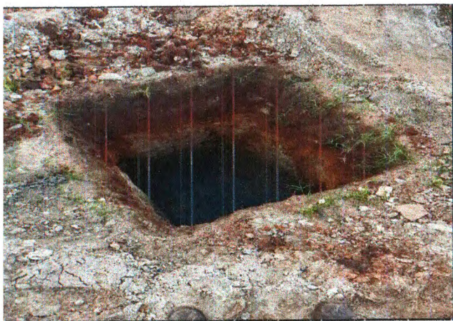
LASTRO DE CONCRETO MAGRO
