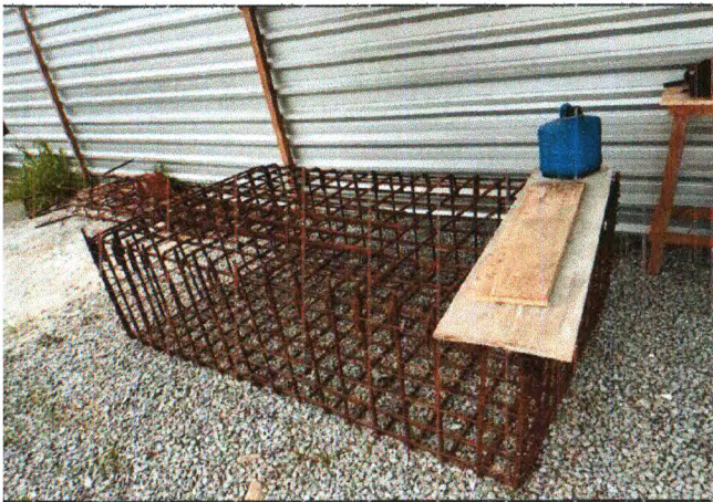
MONTAGEM DE ARMADURA DA FUNDAÇÃO
