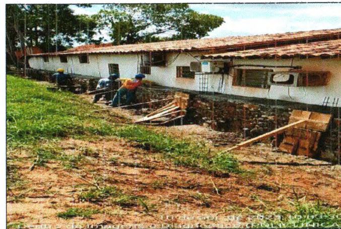
PEDRA CALCÁREA ARGAMASSADA
