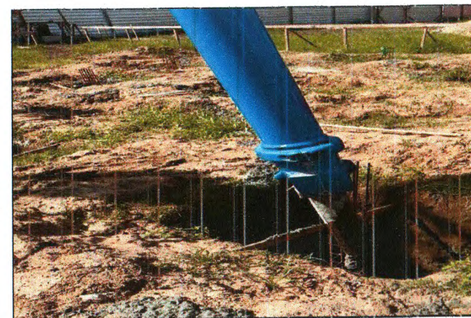
BOMBEAMENTO DO CONCRETO
