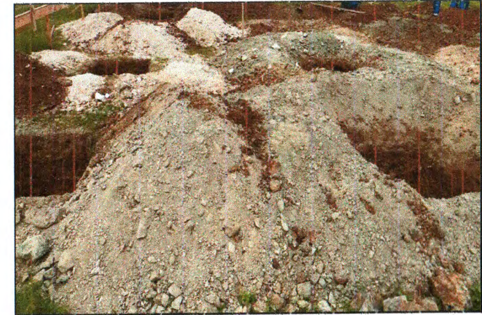
ESCAVAÇÃO DAS SAPATAS
