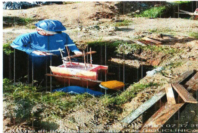
DESFORMA DOS ARRANQUES
