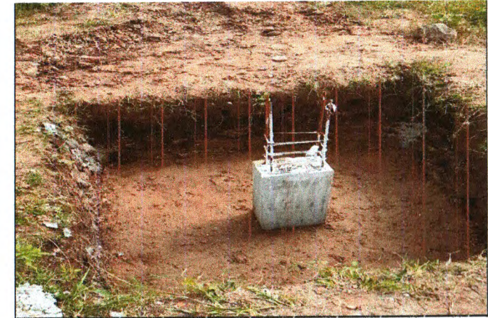
ARRANQUES CONCRETADOS E SAPATAS EM ATERRAMENTO
