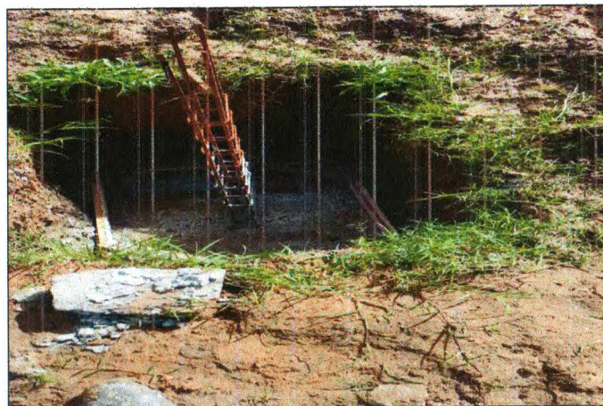
FÓRMA E CONCRETO DAS SAPATAS
