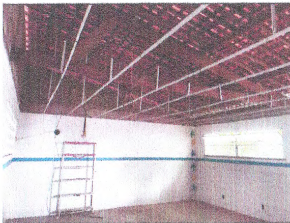
REVISÃO DA COBERTURA EM TELHA CERÂMICA; INSTALAÇÃO ELÉTRICA
