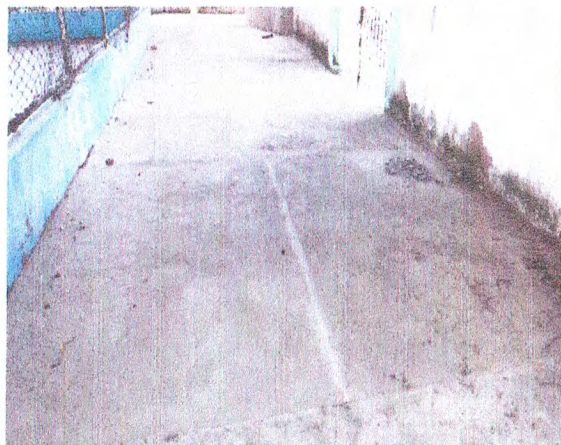
RECUPERAÇÃO DE PISO EM CONCRETO DESEMPOLADO
