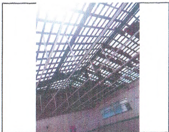
REVISÃO DA COBERTURA EM TELHA CERÂMICA
