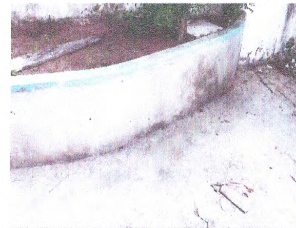
MURETA EM ALVENARIA
