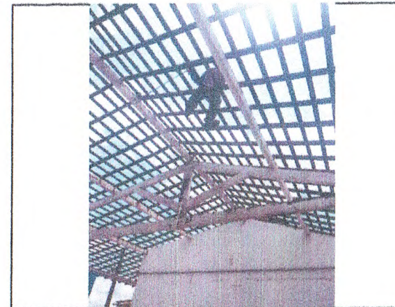
REVISÃO DA COBERTURA EM TELHA CERÂMICA
