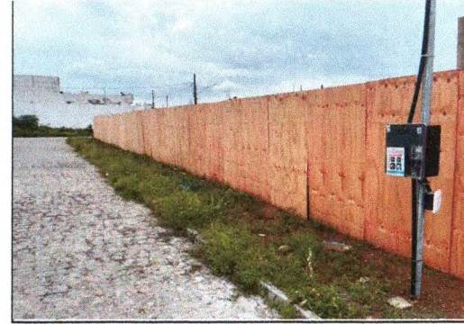
Tapume e instalações provisória de energia
