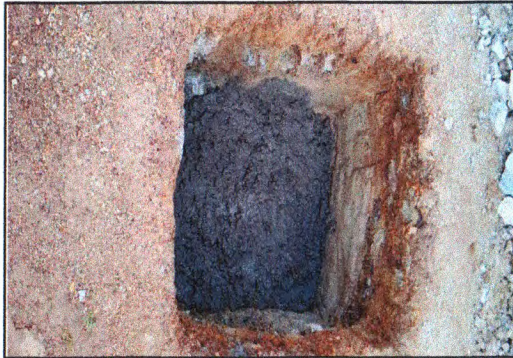
Execução do concreto magro 01
