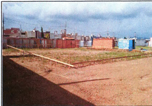
Locação da obra 02
