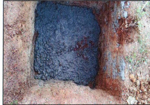
Execução do concreto magro 02
