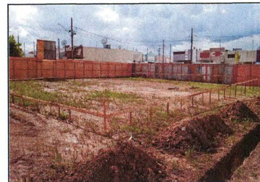
Locação da obra 01
