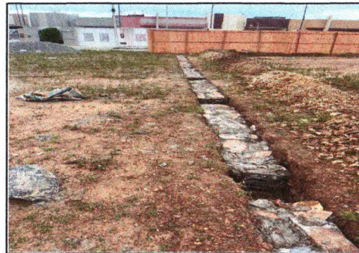
Execução da alvenaria de pedra 02
