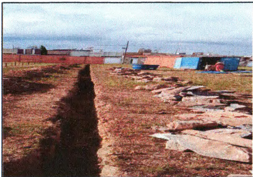
Execução da alvenaria de pedra 01
