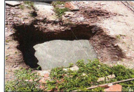
Execução do concreto magro 03
