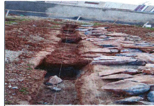
Execução da alvenaria de pedra 03
