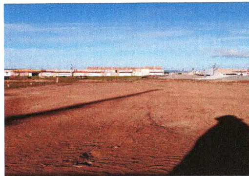
Limpeza e regularização 03
