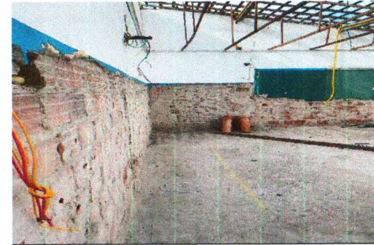
DEMOLIÇÃO DE REBOCO
