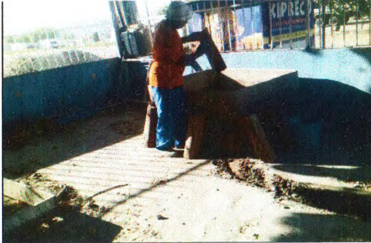
LAVAGEM DE TELHAS
