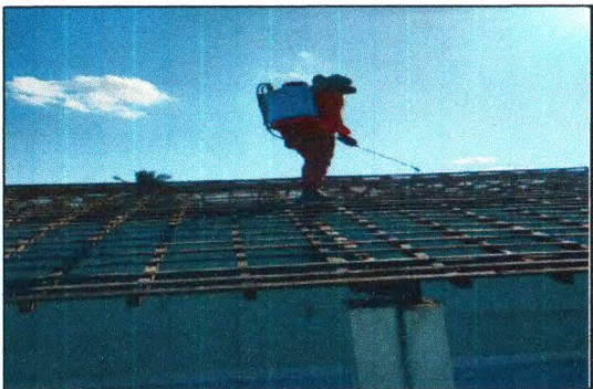
IMUNIZAÇÃO DE TELHADO
