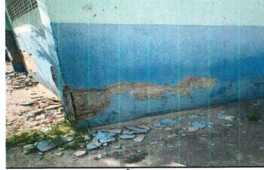
DEMOLIÇÃO DE REBOCO
