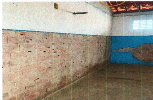
DEMOLIÇÃO DE REBOCO
