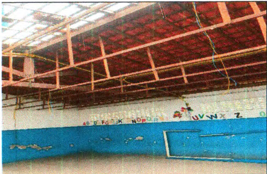
REMOÇÃO DE TELHAMENTO
