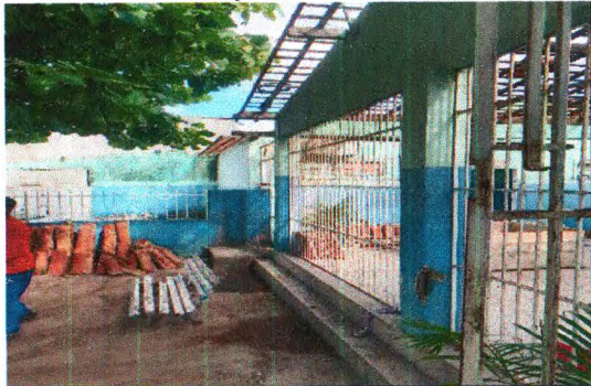
REMOÇÃO DE TELHAMENTO
