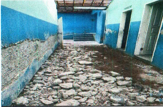
DEMOLIÇÃO DE PISO ALTA RESISTENCIA
