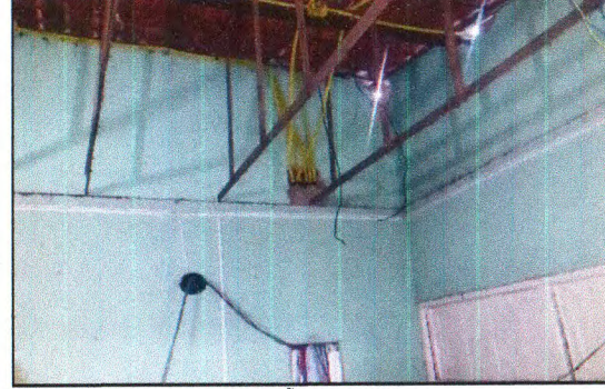
REMOÇÃO DE FORRO
