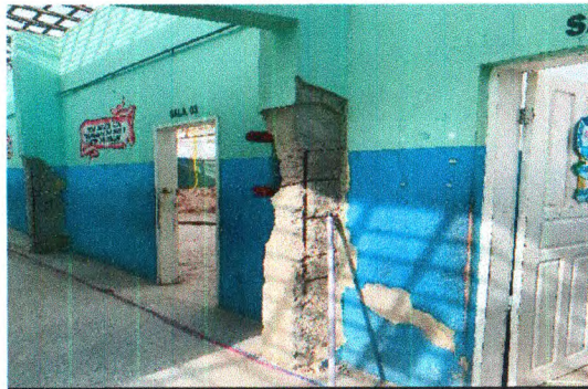
DEMOLIÇÃO DE REBOCO
