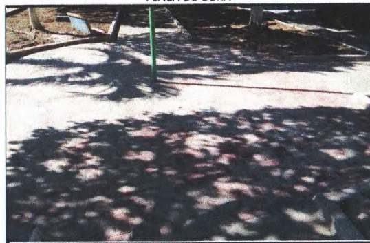
PAVIMENTAÇÃO BLOCO CONCRETO
