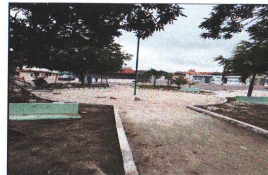
DEMOLIÇÃO MANUAL DE PISO
