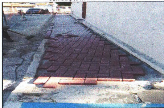
PAVIMENTAÇÃO BLOCO CONCRETO
