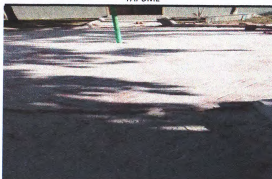
PAVIMENTAÇÃO BLOCO CONCRETO
