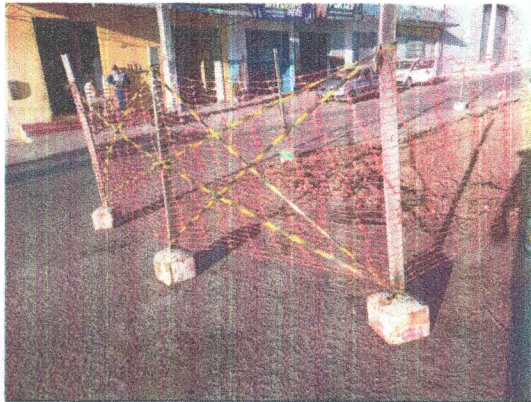
TAPUME DE PROTEÇÃO EM TELA
