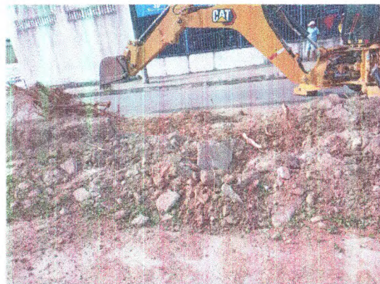
DESTOCAMENTO DE ÁRVORES; ESCAVAÇÃO; CARGA MECANIZADA
