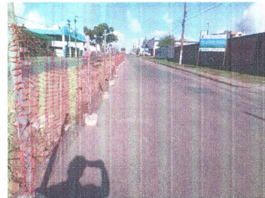
TAPUME DE PROTEÇÃO EM TELA
