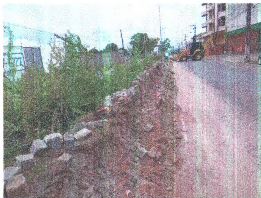
DESTOCAMENTO DE ÁRVORES; DEMOLIÇÃO DE ALVENARIA DE PEDRA; CARGA MECANIZADA
