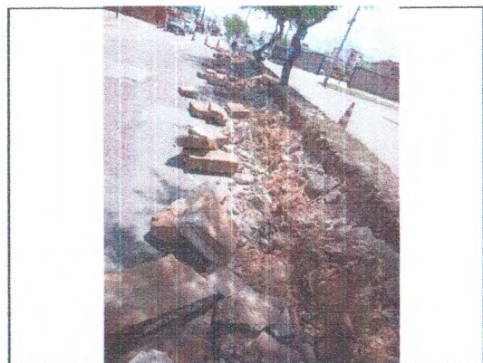
DEMOLIÇÃO DE ALVENARIA DE PEDRA, MEIO-FIO E PISO EM CONCRETO
