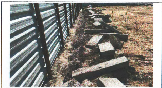
DEMOLIÇÃO DE MEIO FIO
