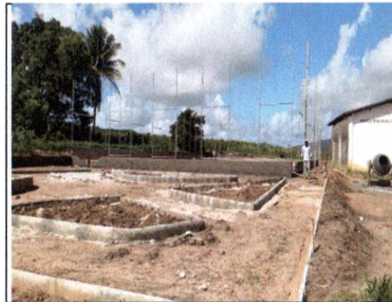
ALAMBRADO; MEIO-FIO; REBOCO
