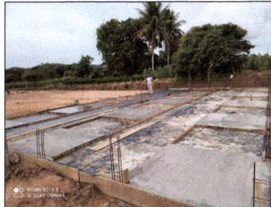
LONA PLÁSTICA E CAMADA IMPERMEABILIZADORA
