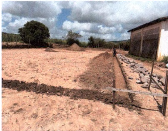
LIMPEZA DO TERRENO; ESCAVAÇÃO; LOCAÇÃO
