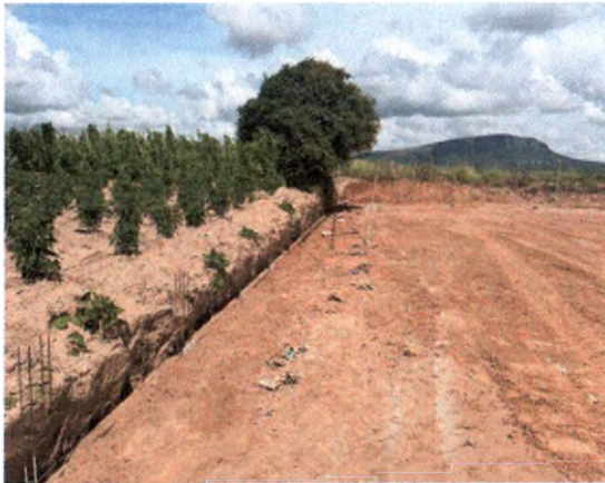
BASE E ARRANQUE DOS PILARES
