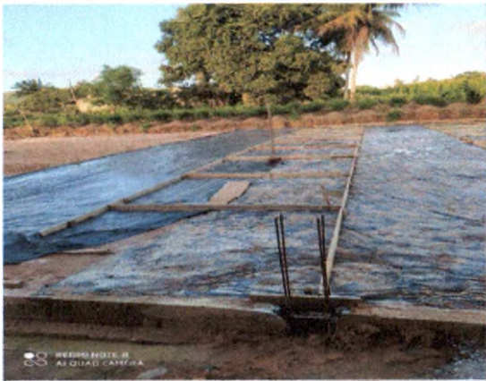
LONA PLÁSTICA E CAMADA IMPERMEABILIZADORA
