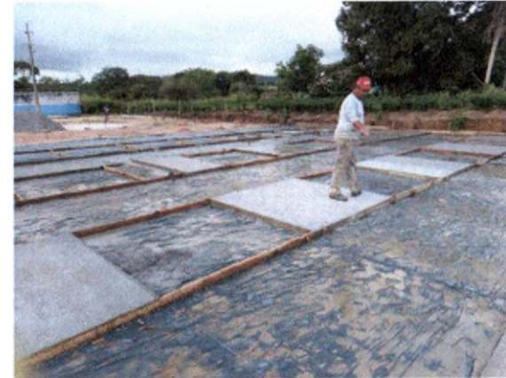
LONA PLÁSTICA E CAMADA IMPERMEABILIZADORA
