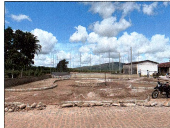
ASSENTAMENTO DE MEIO FIO; PAVIMENTAÇÃO EM PARALELEPÍPEDO
