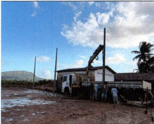
INSTALAÇÃO DO POSTE EM CONCRETO
