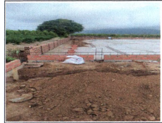
ELEVAÇÃO DA ALVENARIA
