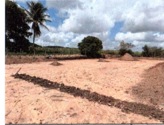
LIMPEZA DO TERRENO; ESCAVAÇÃO
