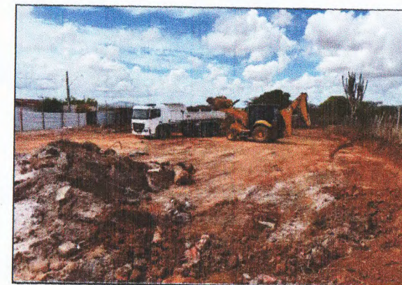
COLETA DO MATERIAL DEMOLIDO
