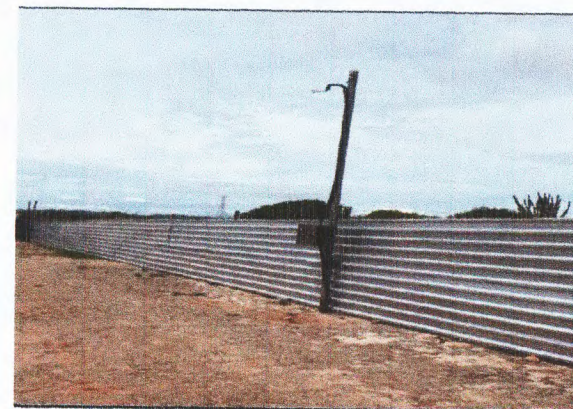
TAPUME METÁLICO E INST. DE ENERGIA
