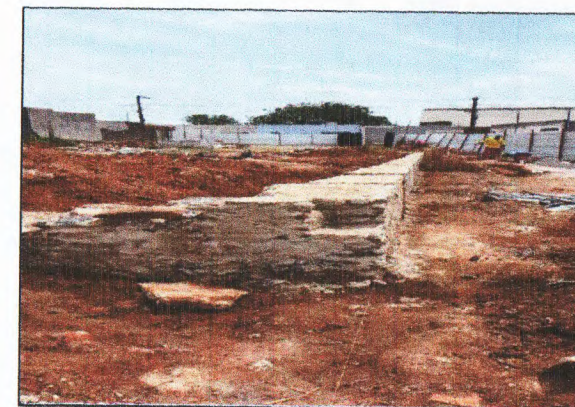
ALVENARIA DE PEDRA DA MURETA
