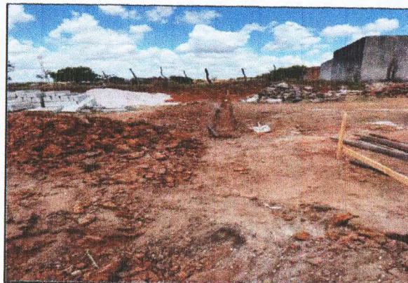
DEMOLIÇÕES E REMOÇÕES
