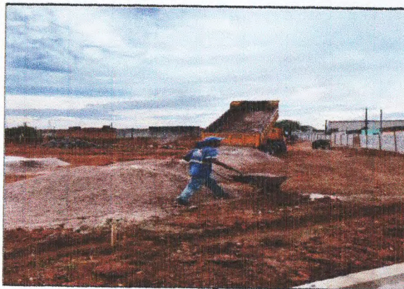
REGULARIZAÇÃO E ATERRO
