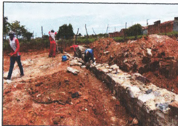
ALVENARIA DE PEDRA DA MURETA
