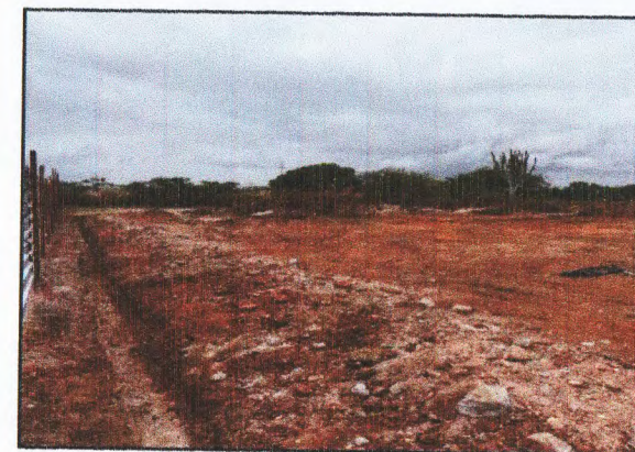
DEMOLIÇÕES E REMOÇÕES
