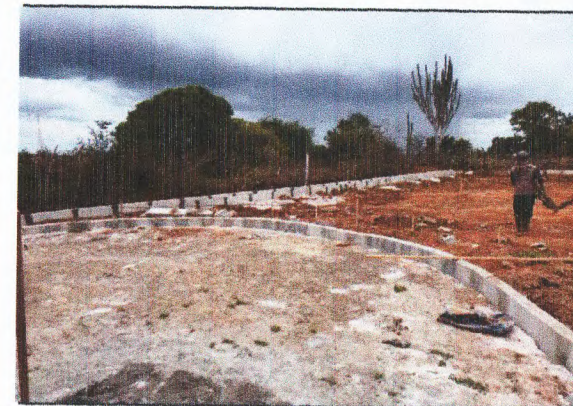
MEIO-FIO, ATERRO E LOCAÇÃO DA PRAÇA
