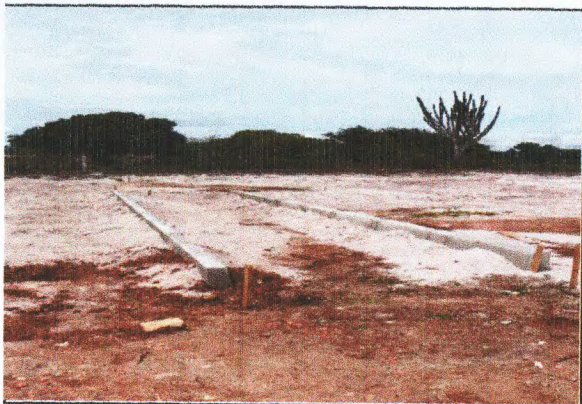
MEIO-FIO, ATERRO E LOCAÇÃO DA PRAÇA
