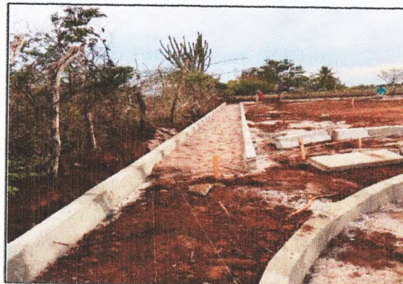
MEIO-FIO E LOCAÇÃO DA PRAÇA
