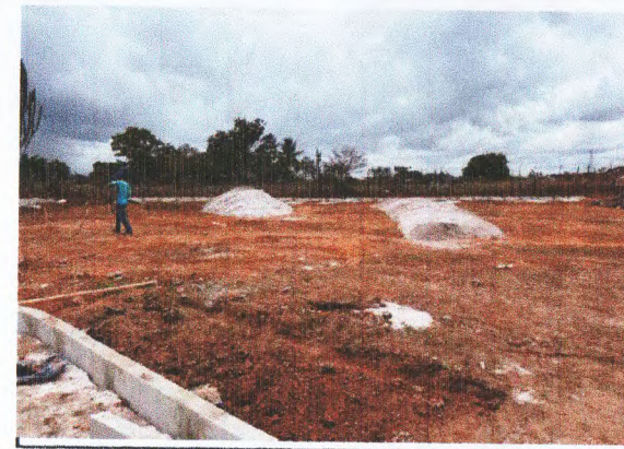
REGULARIZAÇÃO E ATERRO
