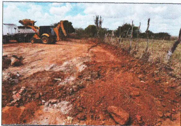
DEMOLIÇÕES E REMOÇÕES
