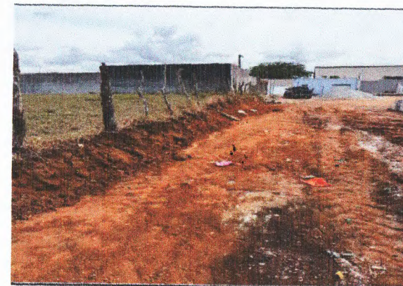
DEMOLIÇÕES E REMOÇÕES
