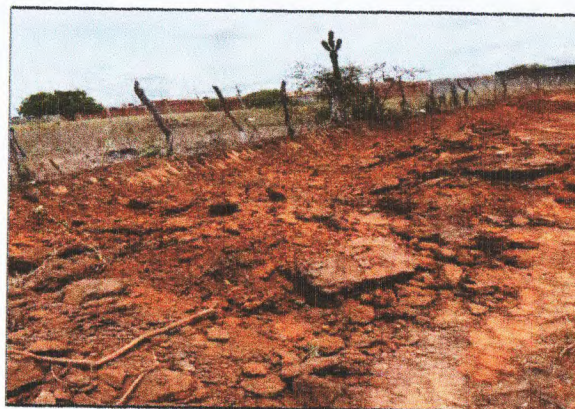
DEMOLIÇÕES E REMOÇÕES
