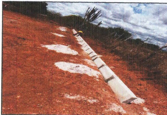
REGULARIZAÇÃO E MEIO-FIO
