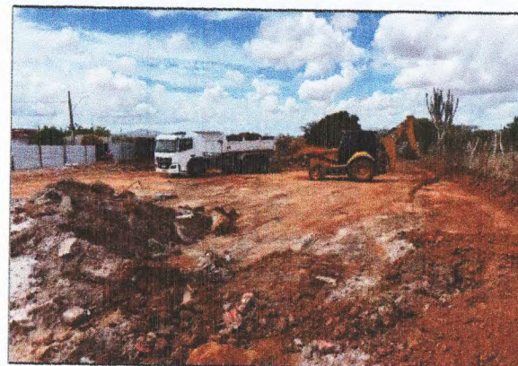
COLETA DO MATERIAL DEMOLIDO
