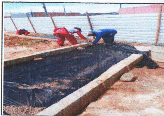
MEIO-FIO E LONA PLÁSTICA
