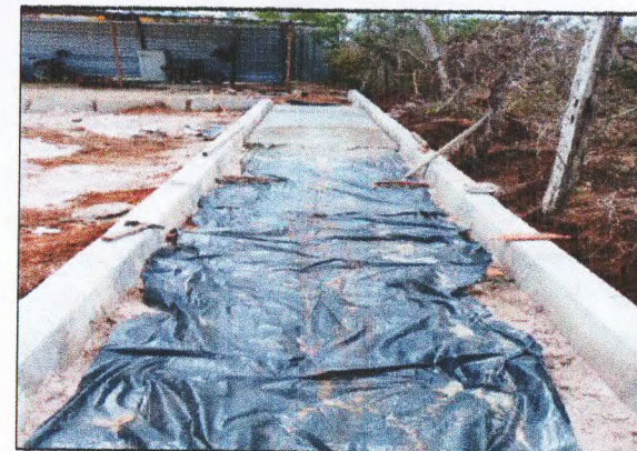
LONA PLÁSTICA E PISO EM CONCRETO
