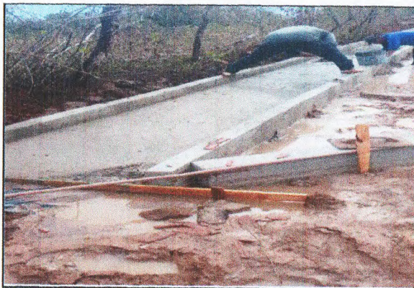
LONA PLÁSTICA E PISO EM CONCRETO
