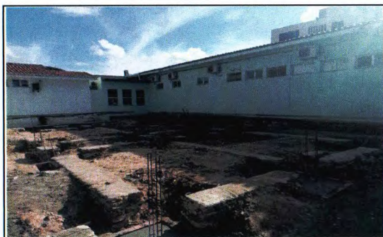
FUNDAÇÃO E ARRANQUE DOS PILARES
