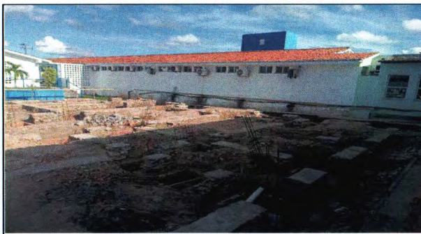
FUNDAÇÃO E ARRANQUE DOS PILARES
