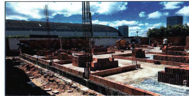
ELEVAÇÃO DA ALVENARIA
