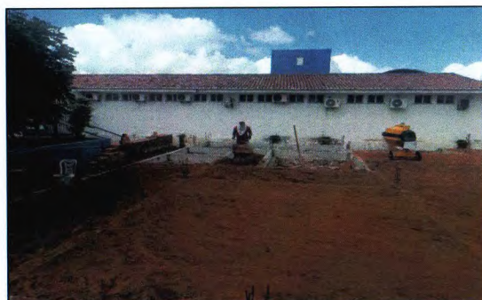
ATERRO DE CAIXÃO
