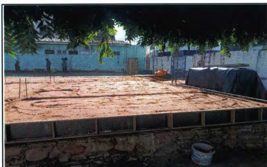
ARMAÇÃO DOS PILARES
