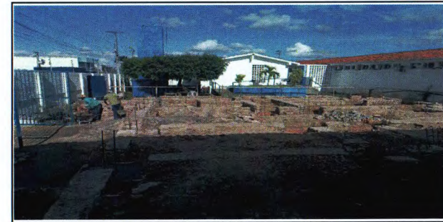
FUNDAÇÃO E ARRANQUE DOS PILARES
