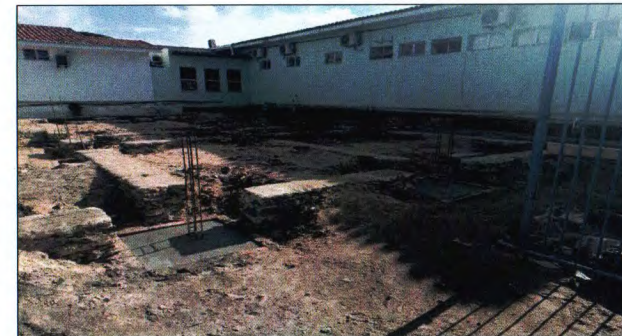
FUNDAÇÃO E ARRANQUE DOS PILARES
