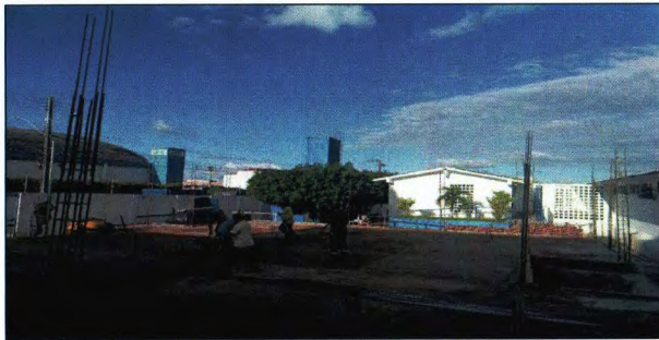
ARMAÇÃO DOS PILARES
