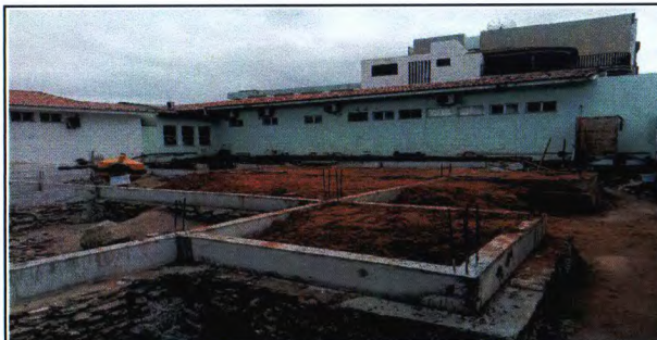
ATERRO DE CAIXÃO
