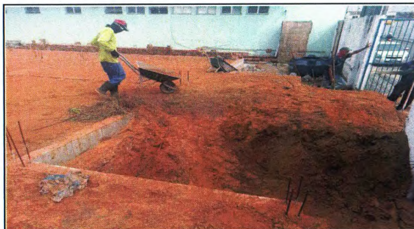
ATERRO DE CAIXÃO
