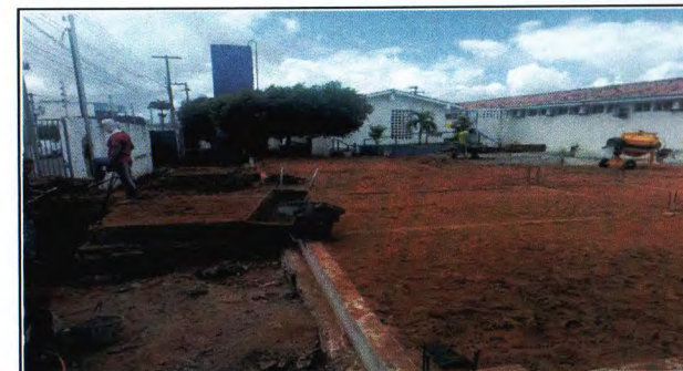
ATERRO DE CAIXÃO
