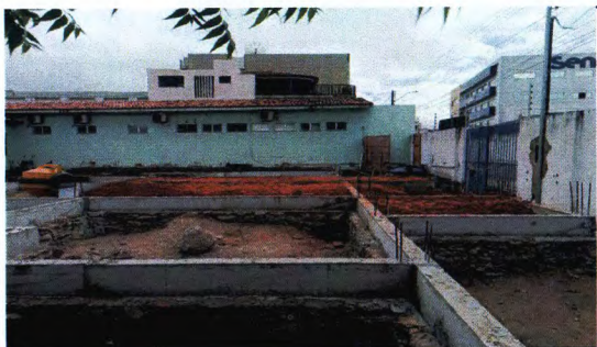
ATERRO DE CAIXÃO
