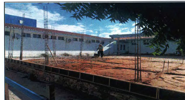
ARMAÇÃO DOS PILARES
