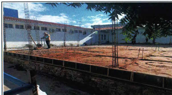
ARMAÇÃO DOS PILARES
