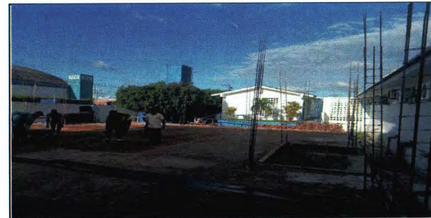
ARMAÇÃO DOS PILARES
