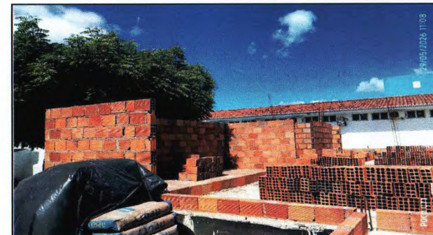
ELEVAÇÃO DA ALVENARIA
