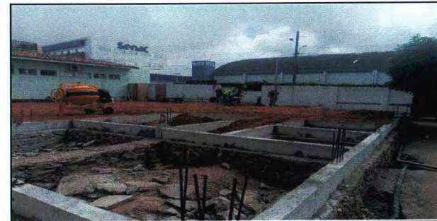
ATERRO DE CAIXÃO
