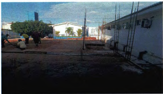
ARMAÇÃO DOS PILARES
