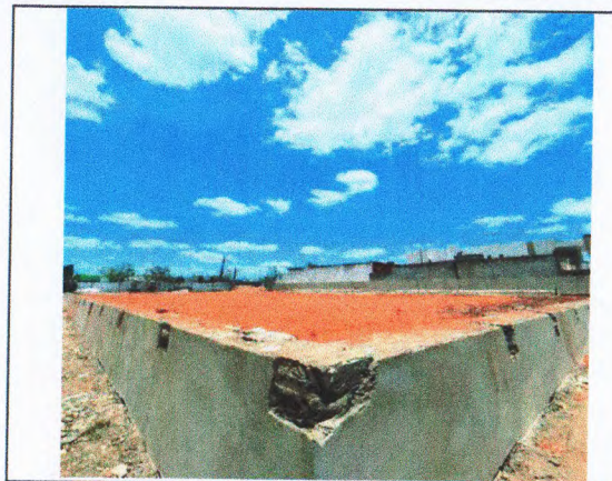
ATERRO; REVESTIMENTO DA CONTENÇÃO EM CHAPISCO E REBOCO.
