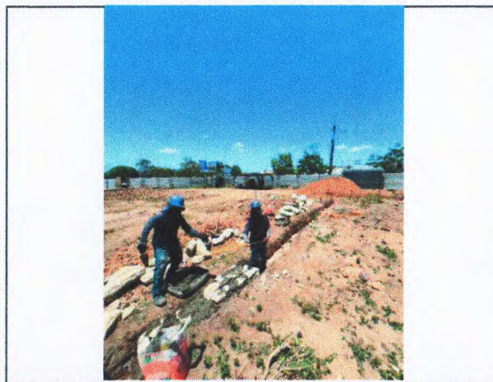
ESCAVAÇÃO E CONTENÇÃO EM ALVENARIA DE PEDRA.
