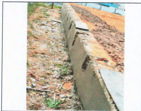
REVESTIMENTO DA CONTENÇÃO EM CHAPISCO E REBOCO.
