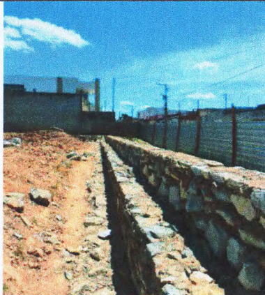
CONTENÇÃO EM ALVENARIA DE PEDRA.
