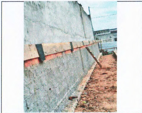
EXECUÇÃO DE MURO.
