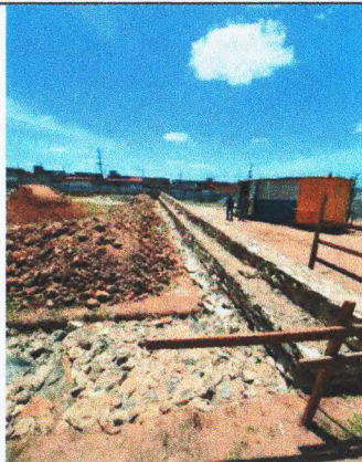
CONTENÇÃO EM ALVENARIA DE PEDRA.
