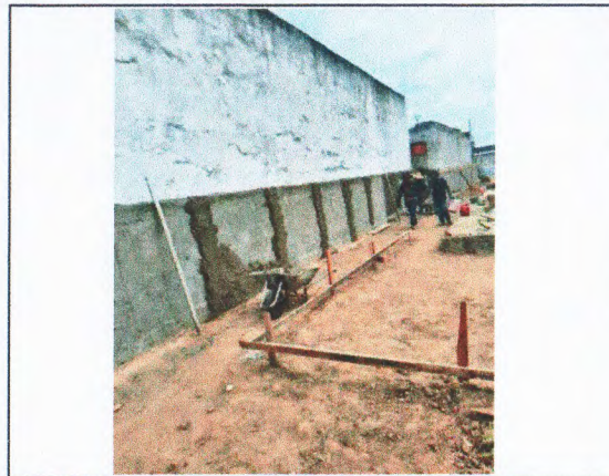
EXECUÇÃO DE MURO.
