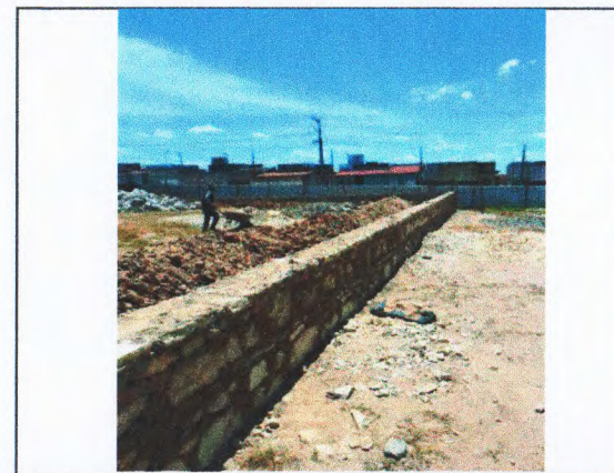
CONTENÇÃO EM ALVENARIA DE PEDRA.
