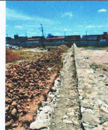
CONTENÇÃO EM ALVENARIA DE PEDRA.
