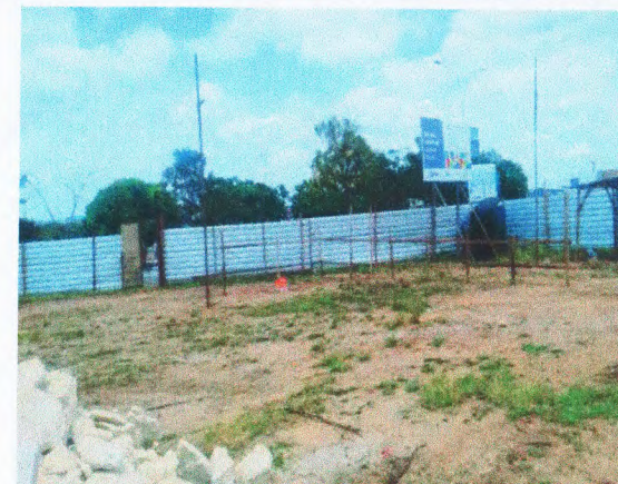
TAPUME EM CHAPA METÁLICA; LOCAÇÃO DA OBRA; LIMPEZA MECANIZADA;
