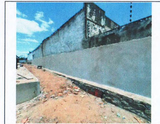
EXECUÇÃO DE MURO.
