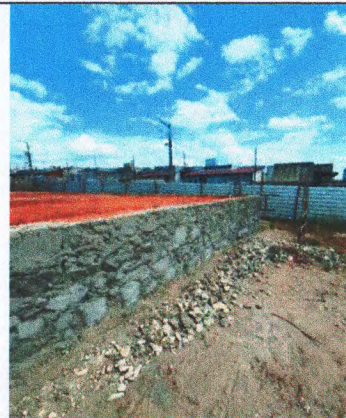
CONTENÇÃO EM ALVENARIA DE PEDRA.
