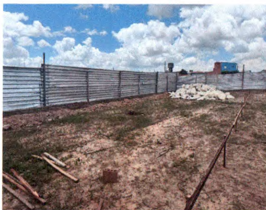
TAPUME E GABARITO DO PRÉDIO
