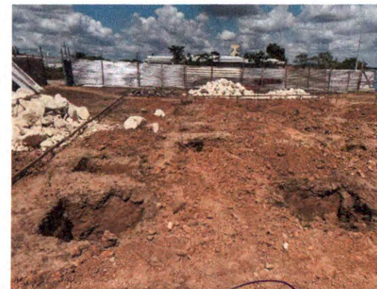
ESCAVAÇÃO, TAPUME E GABARITO
