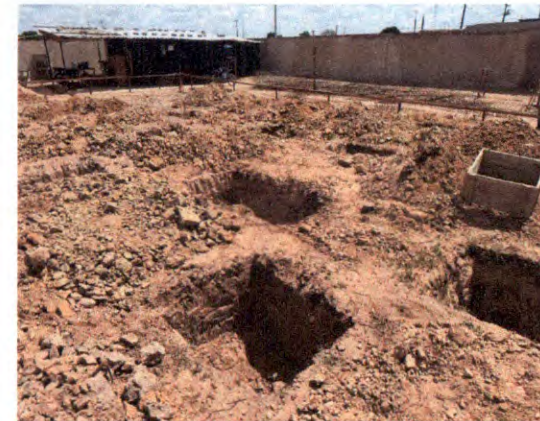
REBOCO, BARRACÃO, GABARITO E ESCAVAÇÃO
