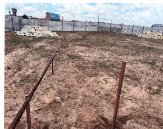
TAPUME E GABARITO DO PRÉDIO
