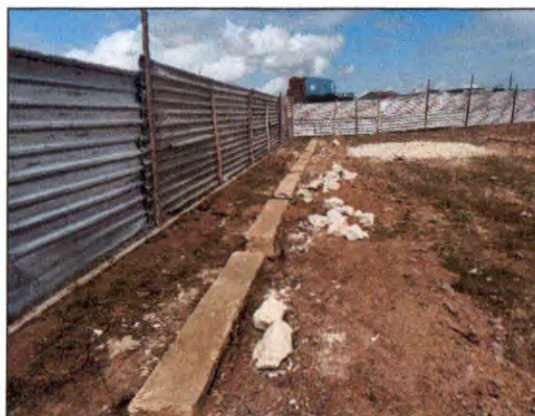
ALVENARIA DE PEDRA DO MURO, TAPUME
