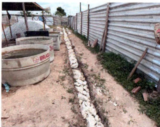
ALVENARIA DE PEDRA DO MURO, TAPUME
