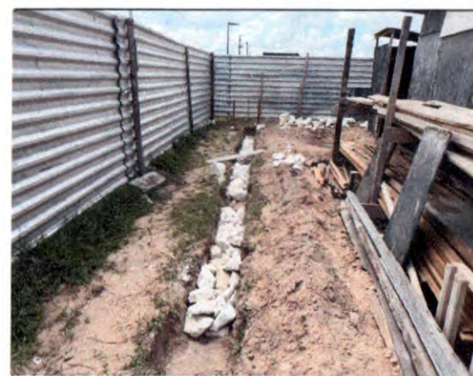
ALVENARIA DE PEDRA DO MURO, TAPUME
