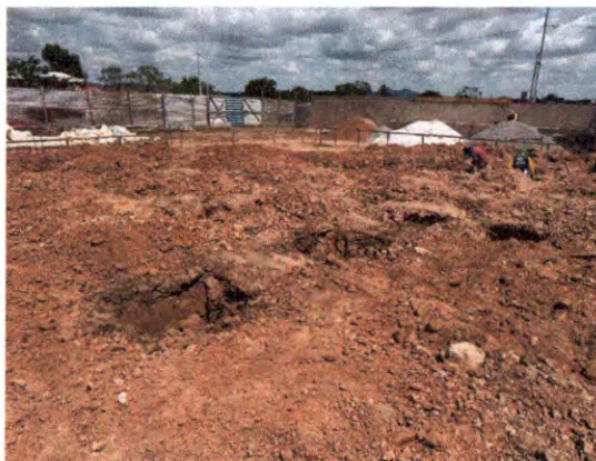
ESCAVAÇÃO, TAPUME E GABARITO
