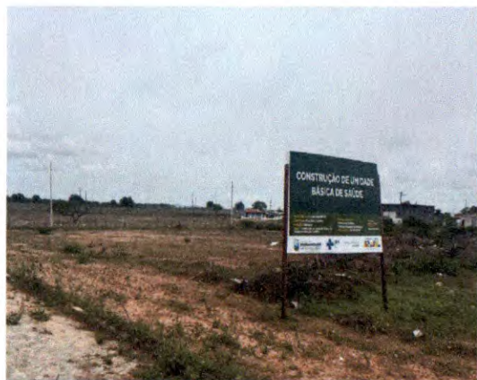
PLACA DA OBRA E LIMPEZA DO TERRENO
