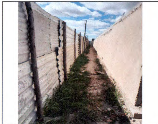
REBOCO E TAPUME
