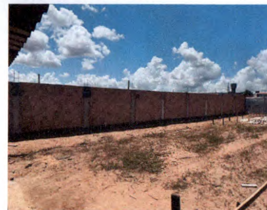
ELEVAÇÃO DE ALVENARIA E CONCRETO ARMADO
