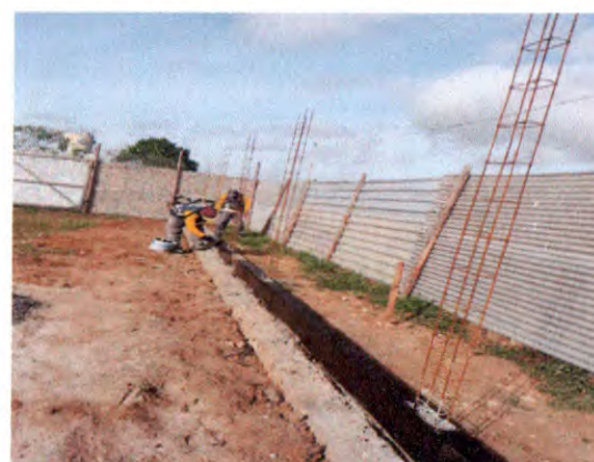
TAPUME, CINTA INFERIOR E IMPERMEABILIZAÇÃO
