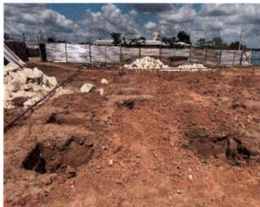
TAPUME, ESCAVAÇÃO E GABARITO
