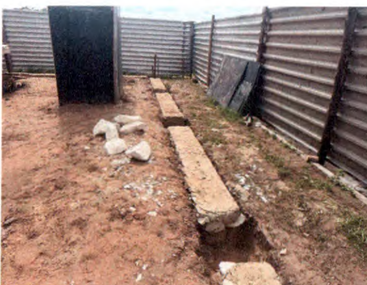
ALVENARIA DE PEDRA DO MURO, TAPUME
