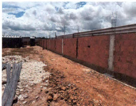
ELEVAÇÃO DE ALVENARIA E CONCRETO ARMADO
