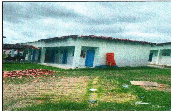
DEMOLIÇÃO DE TELHAMENTO
