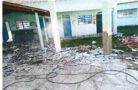
DEMOLIÇÃO DE REVESTIMENTO CERÂMICO
