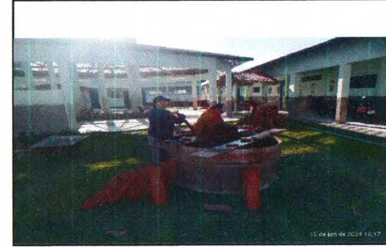
LAVAGEM DE TELHAS
