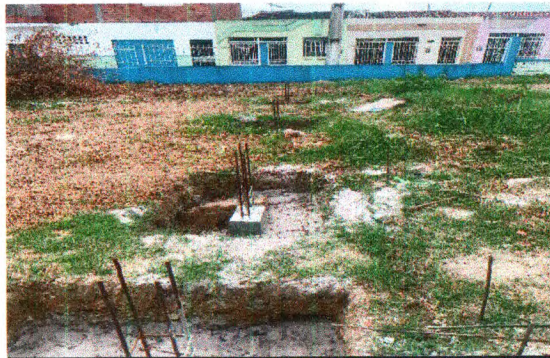
ARRANQUE DOS PILARES
