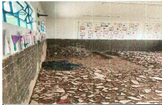
DEMOLIÇÃO DE REVESTIMENTO
