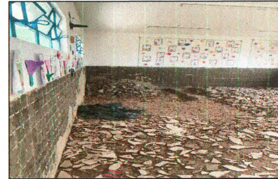
DEMOLIÇÃO DE REVESTIMENTO
