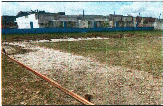
LOCAÇÃO DE EDIFICAÇÃO
