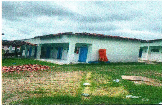
REMOÇÃO DE TELHAMENTO
