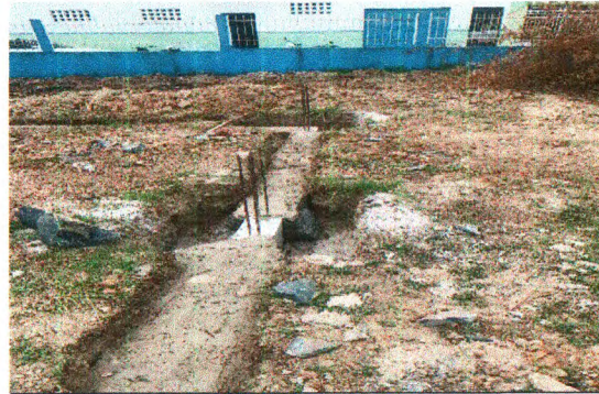
ALVENARIA DE PEDRA
