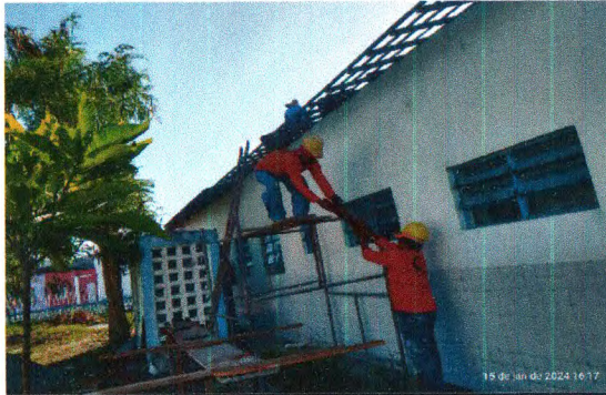
REMOÇÃO DE TELHADO
