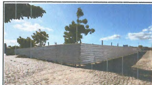
TAPUME COM TELHA METÁLICA
