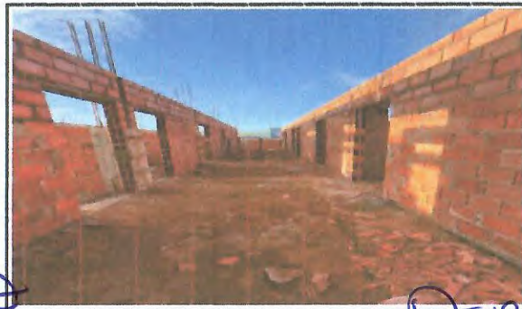
EXECUÇÃO DE ALVENARIA BLOCO CERÂMICO
