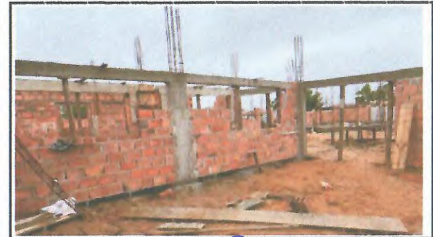
CONCRETAGEM DE VIGAS E EXECUÇÃO DE ALVENARIA
