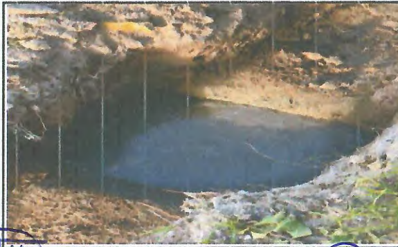
LASTRO DE CONCRETO SIMPLES
