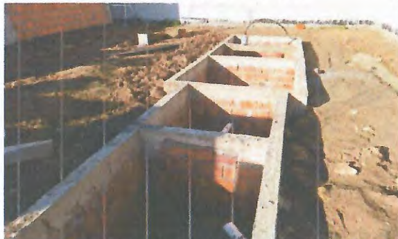
EXECUÇÃO DE ALVENARIA E VIGAS
