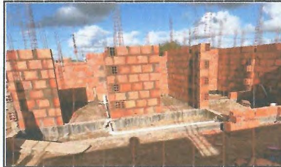
EXECUÇÃO DE ALVENARIA BLOCO CERÂMICO
