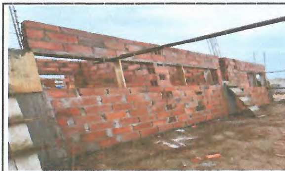
EXECUÇÃO DO MURO EXTERNO
