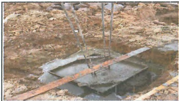
EXECUÇÃO EM CONCRETO ARMADO EM FORMAS
