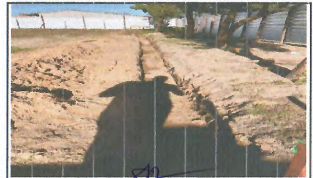
ESCAVAÇÃO MANUAL DE VALA OU CAVA EM MATERIAL
