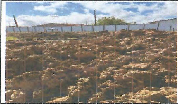
LOCAÇÃO DE GABARITO DE MADEIRA
