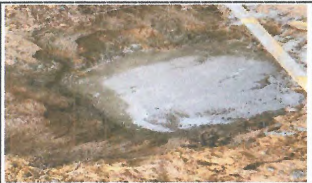
LASTRO DE CONCRETO SIMPLES
