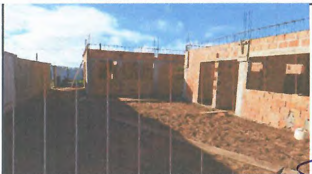
EXECUÇÃO DE ALVENARIA E VIGAS
