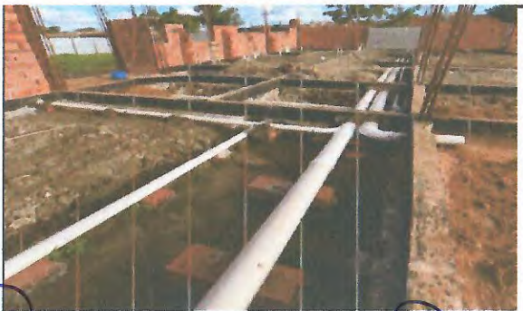
INSTALAÇÕES SANITÁRIAS
