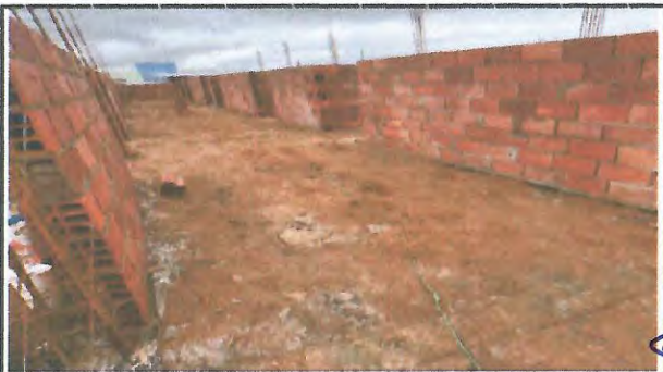
EXECUÇÃO DE ALVENARIA BLOCO CERÂMICO
