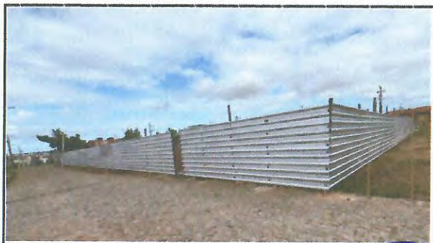
TAPUME COM TELHA METÁLICA
