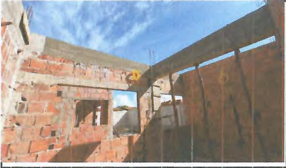
CONCRETAGEM DE VIGAS
