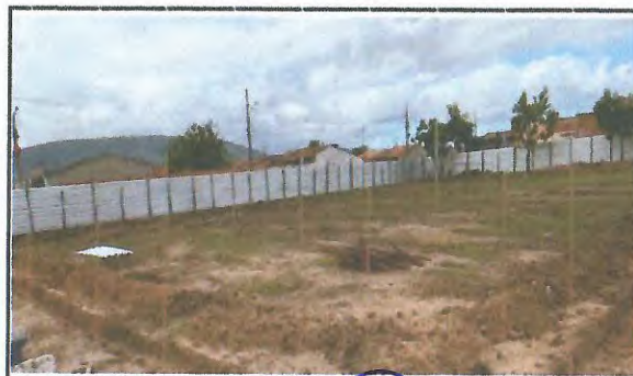
TAPUME COM TELHA METÁLICA
