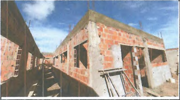
CONCRETAGEM DE VIGAS
