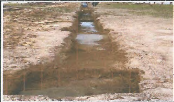
ESCAVAÇÃO MECANIZADA DE VALA OU CAVA EM MATERIAL
