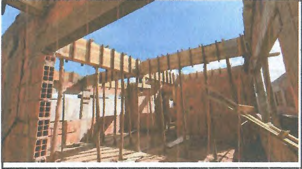
CONCRETAGEM DE VIGAS E ALVENARIA DE BLOCO
