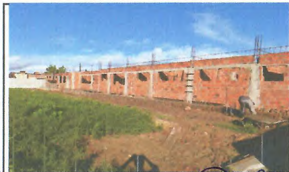
EXECUÇÃO DE ALVENARIA E VIGAS
