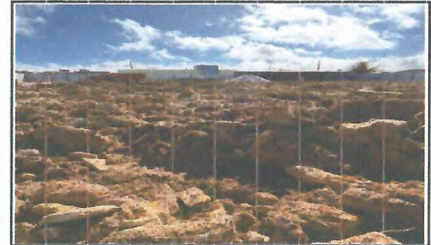
LOCAÇÃO DE GABARITO DE MADEIRA
