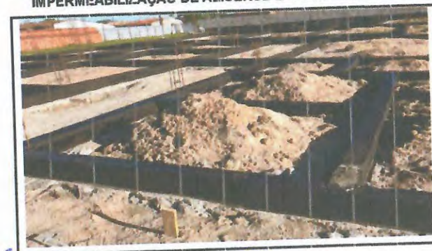
IMPERMEABILIZAÇÃO DE ALICERCE E VIGAS BALDRAME
