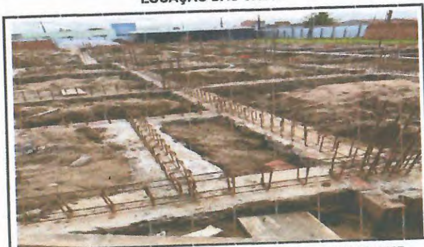
IMPERMEABILIZAÇÃO DE ALICERCE E VIGAS BALDRAME
