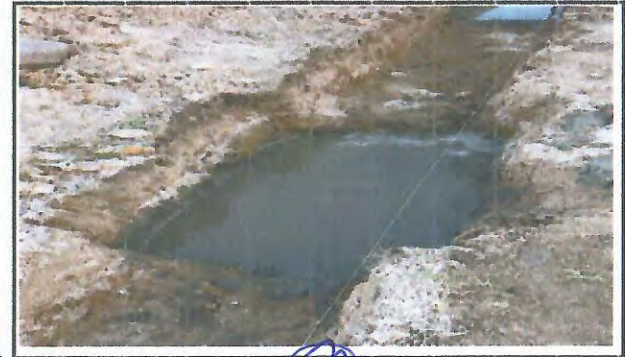
LASTRO DE CONCRETO SIMPLES
