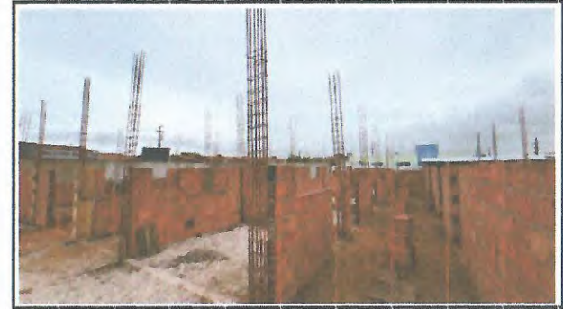
CONCRETAGEM DE VIGAS E EXECUÇÃO DE ALVENARIA
