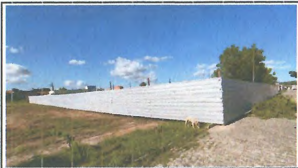
EXECUÇÃO BARRAÇÃO OBRAS
