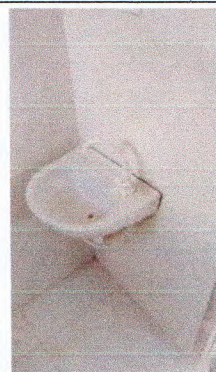
Instalação de pia de louça
