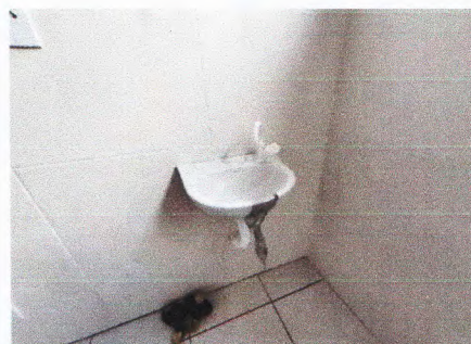
Instalação de pia de louça
