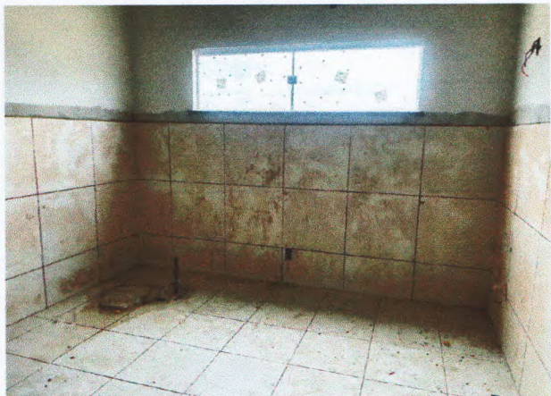
lavagem de parede
