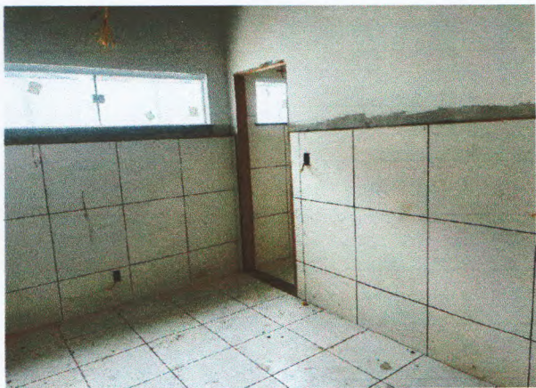
lavagem de parede
