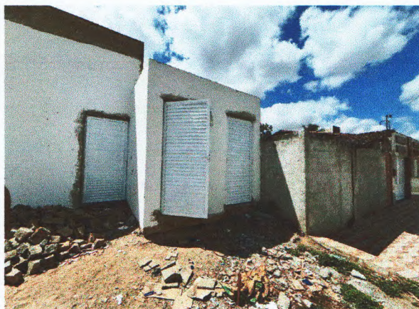
Instalação de portas
