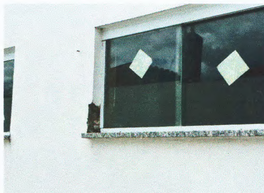
Instalação de vidro
