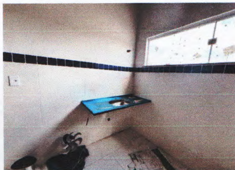
Instalação de pia de inox
