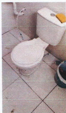
instalação de vaso sanitário
