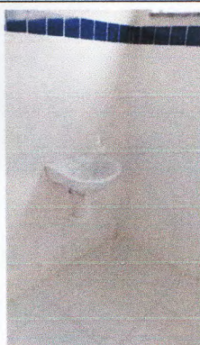
instalação de pia de louça
