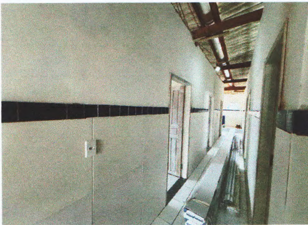
Instalação de portas
