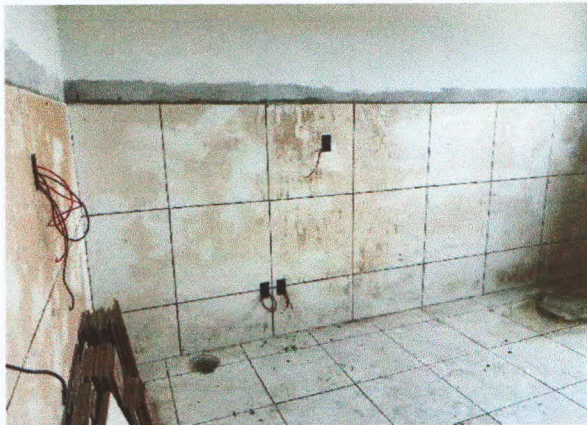
lavagem de parede
