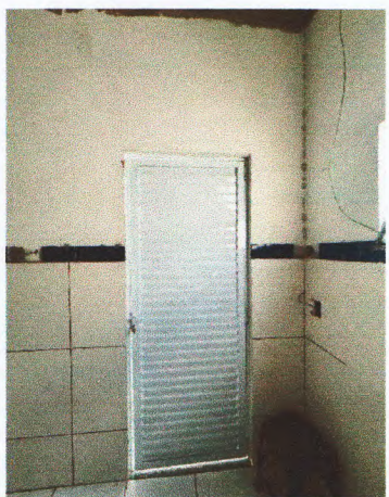
Instalação de portas
