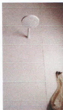
instalação de chuveiro
