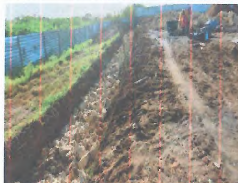
ESCAVAÇÃO - ALVENARIA PEDRA
