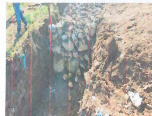
ESCAVAÇÃO - ALVENARIA PEDRA
