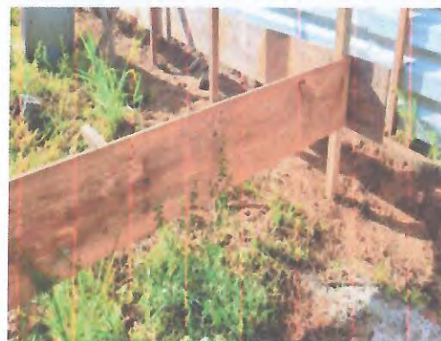
LOCAÇÃO DE OBRA: GABARITO
