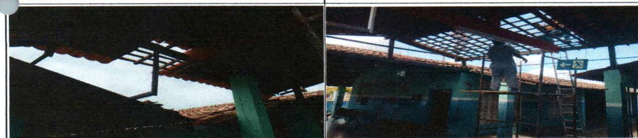
Revisão em cobertura com telha cerâmica tipo canal comum, Itabaiana ou similar, com reposição de 50% do material
