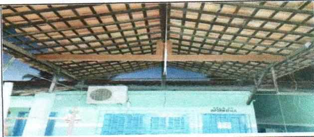
Revisão em cobertura com telha cerâmica tipo canal comum, Itabaiana ou similar, com reposição de 50% do material
