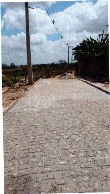
PAVIMENTAÇÃO TANQUE VERMELHO 04
