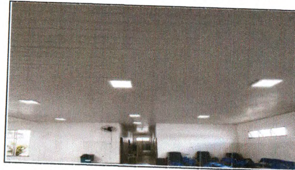
INSTALAÇÃO DE LUMINÁRIA DE SOBREPOR LED
