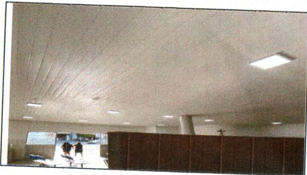
INSTALAÇÃO DE LUMINÁRIA DE SOBREPOR LED
