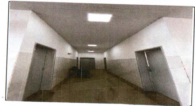
INSTALAÇÃO DE LUMINÁRIA DE SOBREPOR LED
