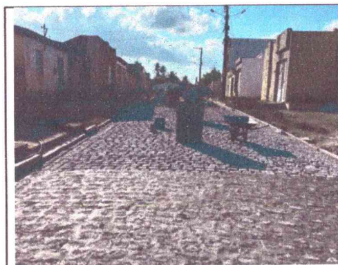
SERVIÇOS DE PAVIMENTAÇÃO
