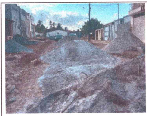
SERVIÇOS DE PAVIMENTAÇÃO
