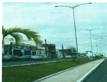
LIMPEZA DE TERRENO - AV. MANOEL FRANCISO TELES
