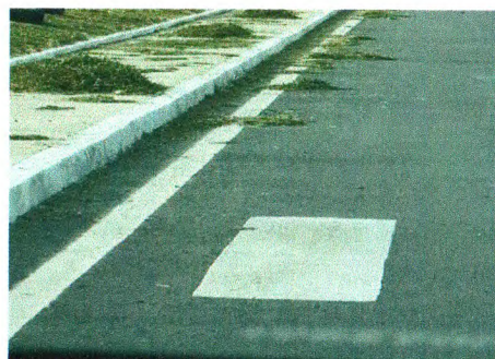
LIMPEZA DE TERRENO - AV. MANOEL FRANCISO TELES
