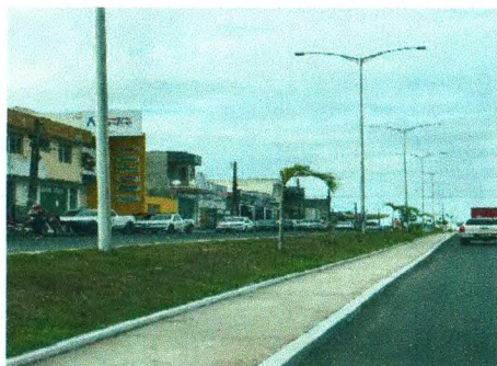
LIMPEZA DE TERRENO - AV. MANOEL FRANCISO TELES
