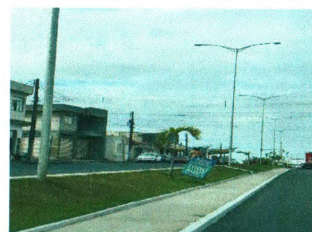
LIMPEZA DE TERRENO - AV. MANOEL FRANCISO TELES
