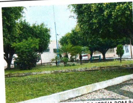
LIMPEZA DE TERRENO - PRAÇA DA IGREJA BOM PARTO
