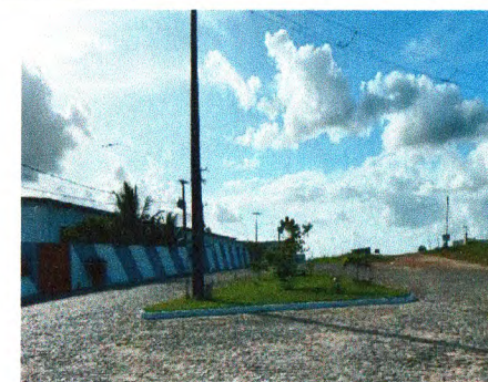
PINTURA DE MEIO-FIO - ACESSO AO DISTRITO INDUSTRIAL
