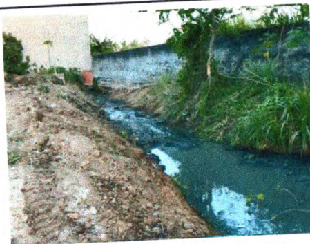
LIMPEZA DE CANAL - PROXIMIDADES DA AV. MANOEL FRANCISCO TELES
