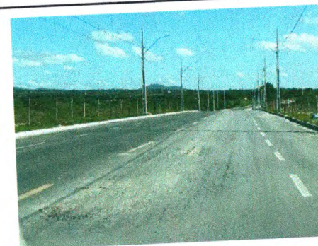
PINTURA DE MEIO-FIO - ACESSO AO CONJUNTO SERAPIÃO ANTÔNIO DE GÓIS
