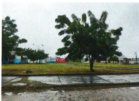
LIMPEZA DE TERRENO - PRAÇA MARIA CONCEIÇÃO
