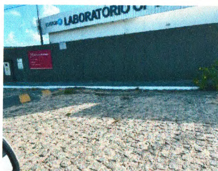
PINTURA DE MEIO-FIO - ACESSO AO DISTRITO INDUSTRIAL
