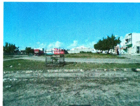
LIMPEZA DE TERRENO - PRAÇA MARIA CONCEIÇÃO
