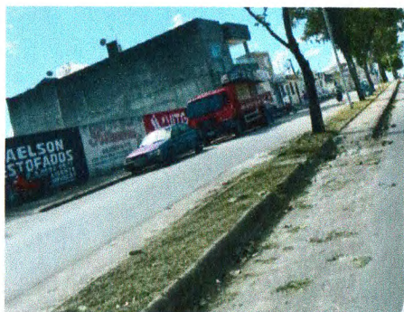
LIMPEZA DE TERRENO - AV. ANTÔNIO CORNÉLIO DA FONSECA
