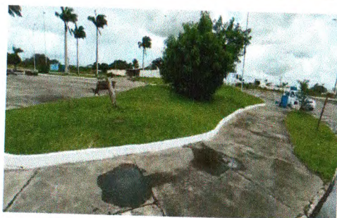
PINTURA DE CANTEIROS - PRAÇA VILLA LOBOS
