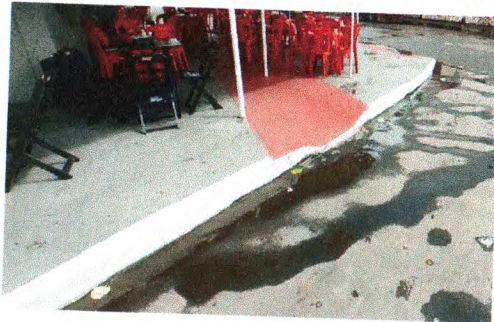
PINTURA DE MEIO-FIO - CALÇADÃO DR. AIRTON TELES
