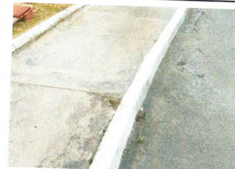
PINTURA DE MEIO-FIO - PÓRTICO ENTRADA DA CIDADE
