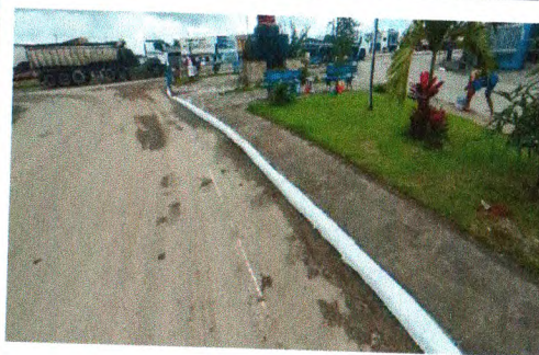
PINTURA DE MEIO-FIO - PÓRTICO AV. MANOEL ANTÔNIO DOS SANTOS
