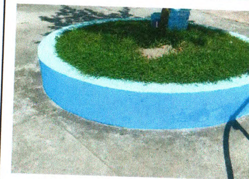
EMASSAMENTO E PINTURA- AV. DR. AIRTON TELES
