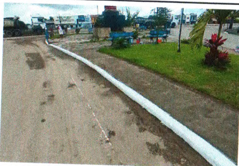
LIMPEZA - PÓRTICO AV. MANOEL ANTÔNIO DOS SANTOS
