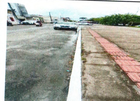
PINTURA DE MEIO-FIO - CALÇADÃO DR. AIRTON TELES
