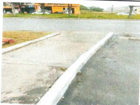
PINTURA DE MEIO-FIO - PÓRTICO ENTRADA DA CIDADE
