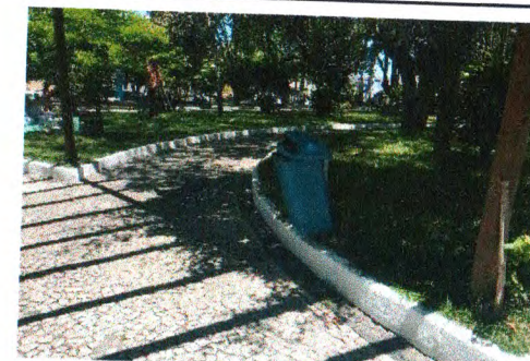
PINTURA DE CANTEIROS - PRAÇA FAUSTO CARDOSO
