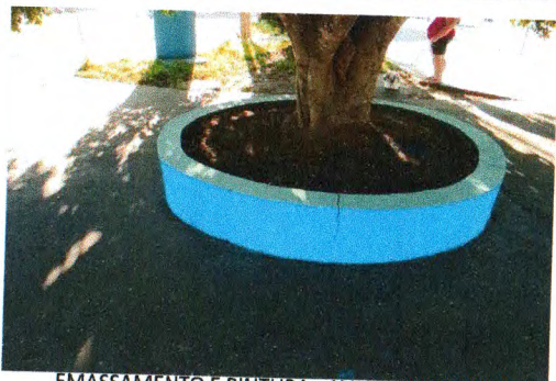
EMASSAMENTO E PINTURA- AV. DR. AIRTON TELES
