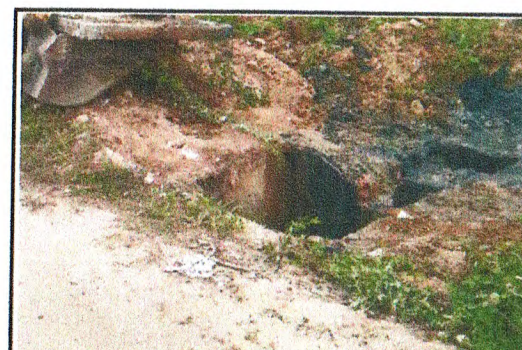
LIMPEZA DE CAIXAS- DIVERSAS RUAS DA CIDADE
