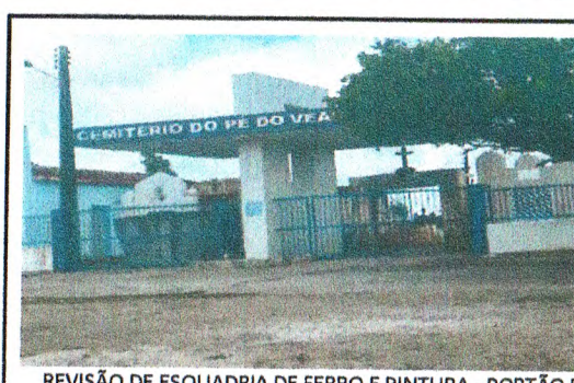
REVISÃO DE ESQUADRIA DE FERRO E PINTURA - PORTÃO DO CEMITÉRIO DO PÉ DO VEADO
