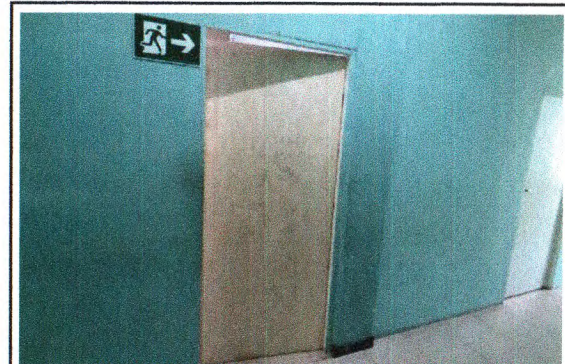
INSTALAÇÃO DE PORTA - SEDE DA SECRETARIA DE OBRAS
