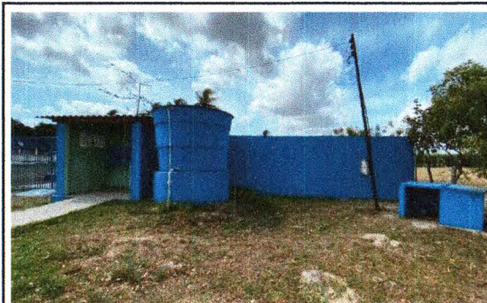
EMASSAMENTO E PINTURA - LAVANDERIA DO POVOADO GANDÚ 2
