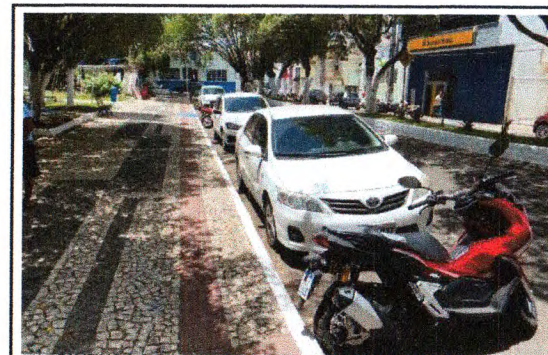
PINTURA DE MEIO-FIO - PRAÇA FAUSTO CARDOSO E RUAS ADJACENTES
