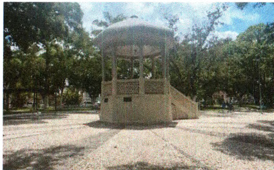
EMASSAMENTO E PINTURA - CORETO DA PRAÇA FRUSTO CARDOSO
