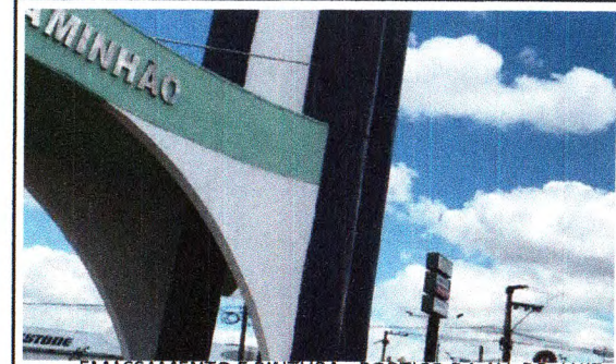
EMASSAMENTO E PINTURA - PÓRTICO DA AV. DR. LUIZ MAGALHÃES
