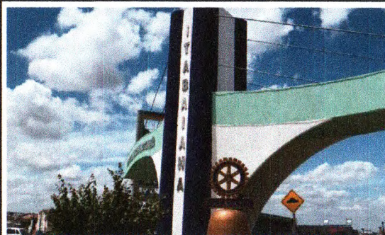
EMASSAMENTO E PINTURA - PÓRTICO DA AV. DR. LUIZ MAGALHÃES
