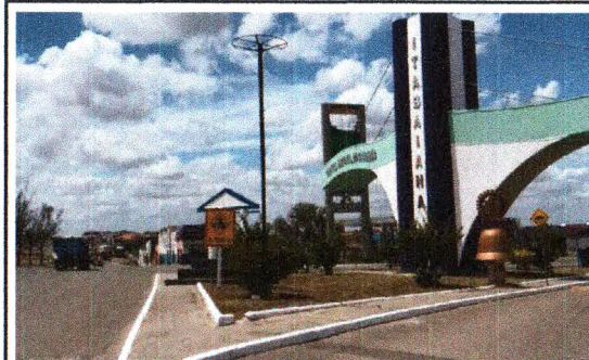
PINTURA DE CANTEIROS E MEIO-FIO - PÓRTICO DA AV. DR. LUIZ MAGALHÃES
