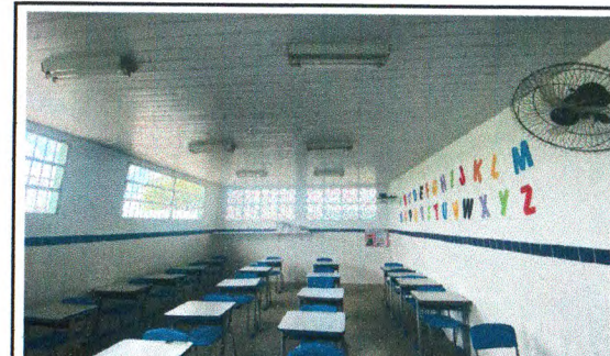
FORRO DE PVC: ESCOLA MUNICIPAL JOSÉ FILADELFO ARAUJO
