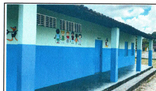
PINTURA E EMASSAMENTO - ESCOLA MUNICIPAL MARIA CLIMÉRIA DE JESUS
