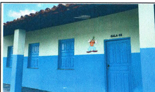
PINTURA E EMASSAMENTO - ESCOLA MUNICIPAL MARIA CLIMÉRIA DE JESUS
