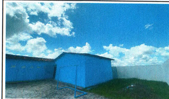
EMASSAMENTO E PINTURA: ESCOLA MUNICIPAL JOSÉ FILADELFO ARAUJO
