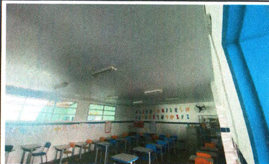
FORRO DE PVC: ESCOLA MUNICIPAL JOSÉ FILADELFO ARAUJO
