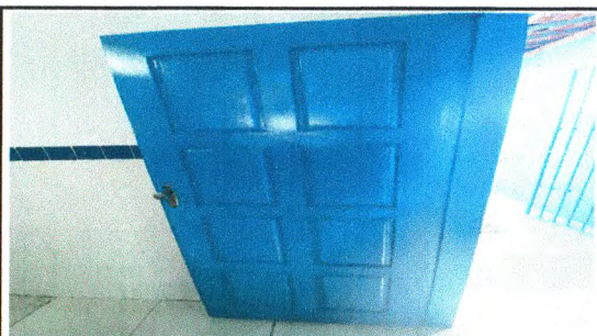
PINTURA DE ESQUADRIA DE MADEIRA - ESCOLA MUNICIPAL JOSÉ FILADELFO ARAUJO
