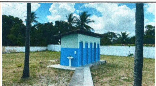
PINTURA E EMASSAMENTO - ESCOLA MUNICIPAL MARIA CLIMÉRIA DE JESUS
