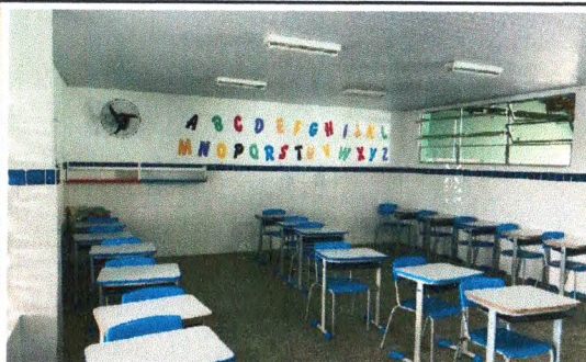
EMASSAMENTO E PINTURA: ESCOLA MUNICIPAL JOSÉ FILADELFO ARAUJO
