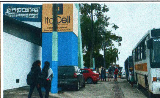
PINTURA E EMASSAMENTO - PRAÇA DE EVENTOS
