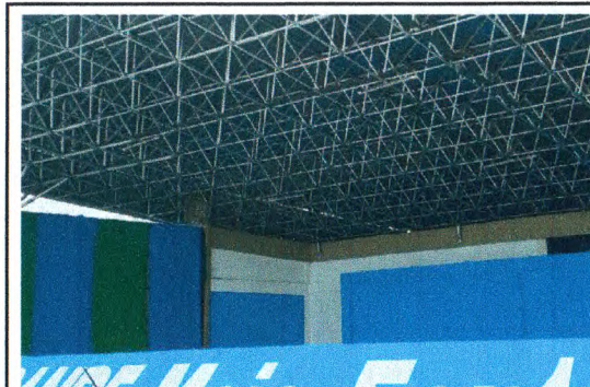
PINTURA E EMASSAMENTO - PRAÇA DE EVENTOS
