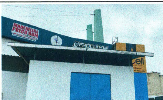
PINTURA, EMASSAMENTO E CALHA EM CHAPA DE AÇO - PRAÇA DE EVENTOS
