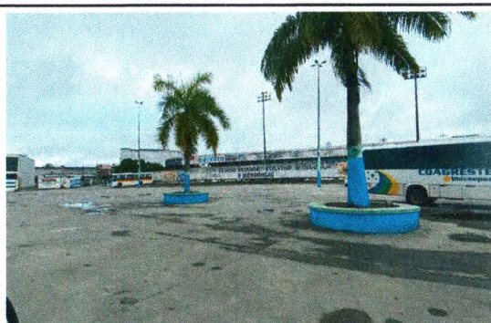
PINTURA E EMASSAMENTO - PRAÇA DE EVENTOS
