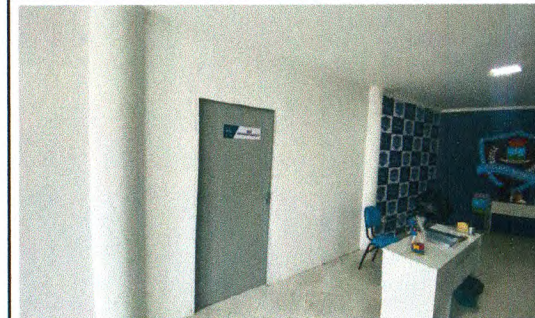
EMASSAMENTO, PINTURA, FORRO DE GESSO - SEDE DA GUARDA MUNICIPAL
