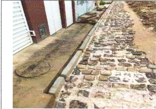
ASSENTAMENTO DE MEIO FIO
