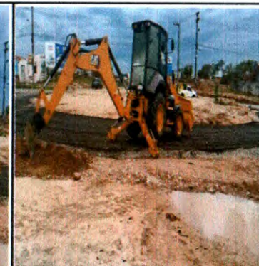
ESCAVAÇÃO E ATERRO PARA MEIO-FIO PRÉ MOLDADO
