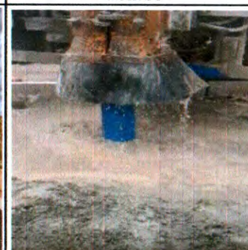
PERFURAÇÃO, REVESTIMENTO E CIMENTAÇÃO DO POÇO ARTESIANO
