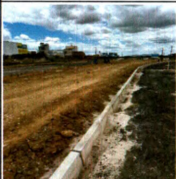
MEIO-FIO PRÉ MOLDADO DE CONCRETO
