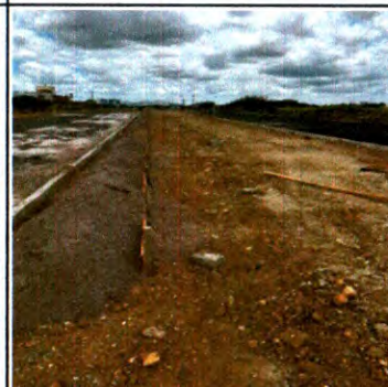
MEIO-FIO PRÉ MOLDADO DE CONCRETO
