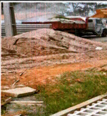
ESCAVAÇÃO E ATERRO PARA MEIO-FIO PRÉ MOLDADO
