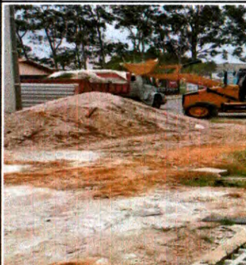
ESCAVAÇÃO E ATERRO PARA MEIO-FIO PRÉ MOLDADO
