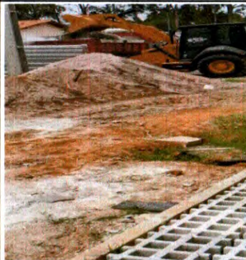
ESCAVAÇÃO E ATERRO PARA MEIO-FIO PRÉ MOLDADO
