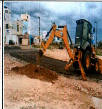
ESCAVAÇÃO E ATERRO PARA MEIO-FIO PRÉ MOLDADO
