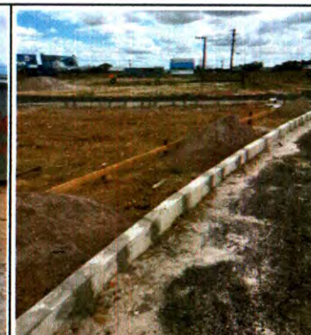
MEIO-FIO PRÉ MOLDADO DE CONCRETO
