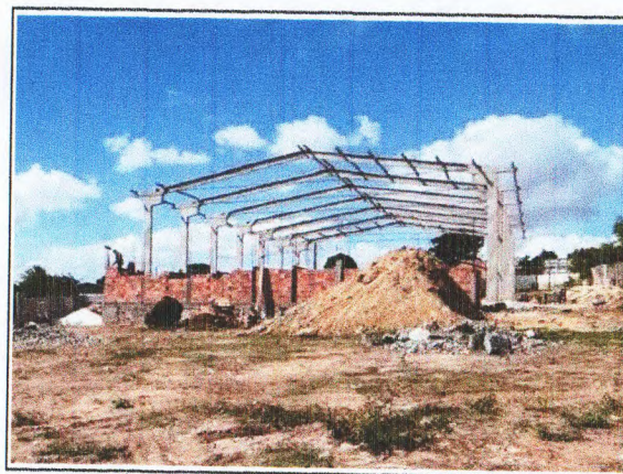
MONTAGEM DA ESTRUTURA DO GALPÃO
