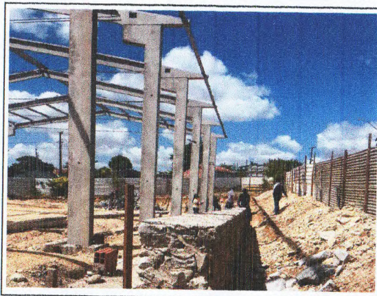
MONTAGEM DA ESTRUTURA DO GALPÃO
