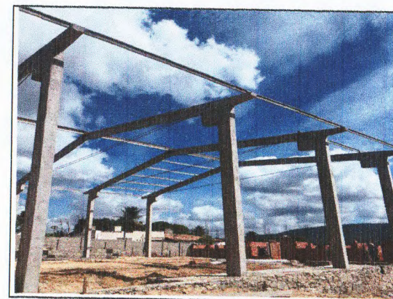
MONTAGEM DA ESTRUTURA DO GALPÃO
