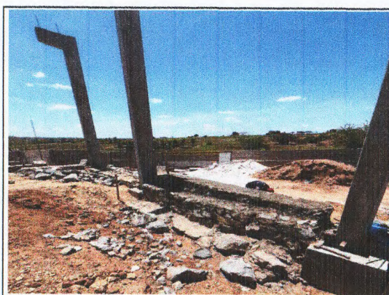
MONTAGEM DA ESTRUTURA DO GALPÃO
