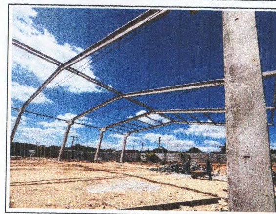
MONTAGEM DA ESTRUTURA DO GALPÃO
