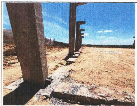
MONTAGEM DA ESTRUTURA DO GALPÃO
