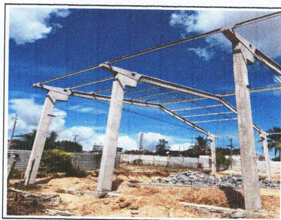
MONTAGEM DA ESTRUTURA DO GALPÃO
