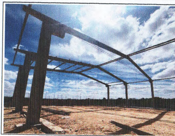
MONTAGEM DA ESTRUTURA DO GALPÃO
