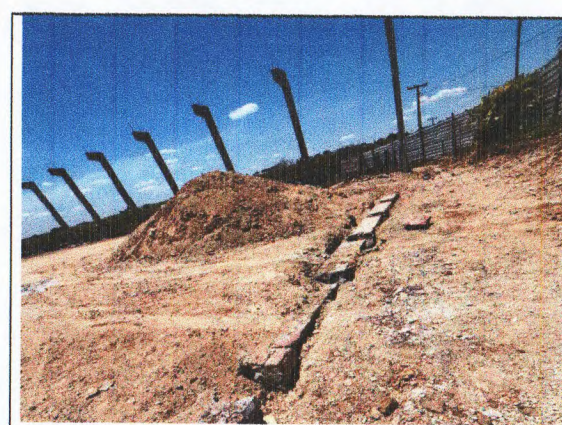
MONTAGEM DA ESTRUTURA DO GALPÃO
