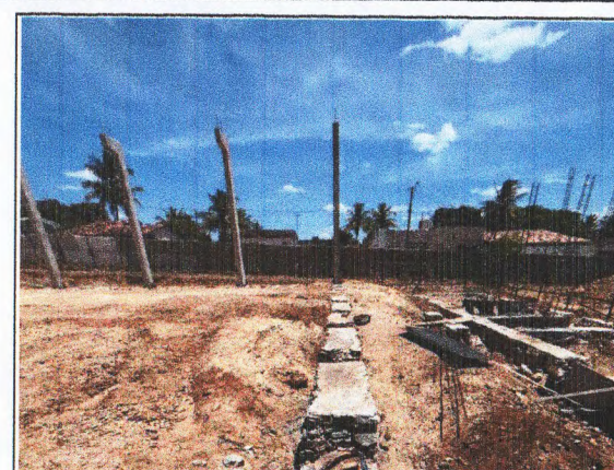
MONTAGEM DA ESTRUTURA DO GALPÃO
