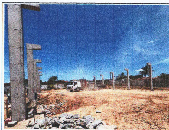
MONTAGEM DA ESTRUTURA DO GALPÃO
