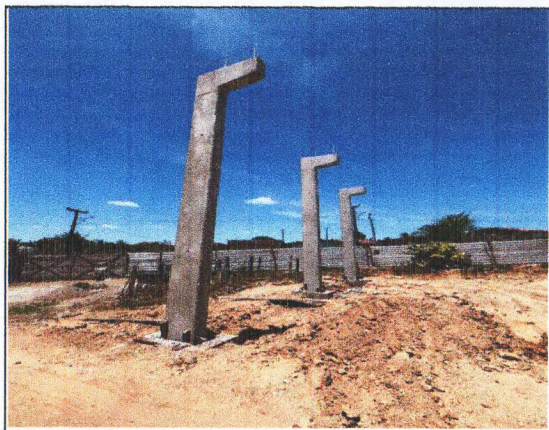
MONTAGEM DA ESTRUTURA DO GALPÃO
