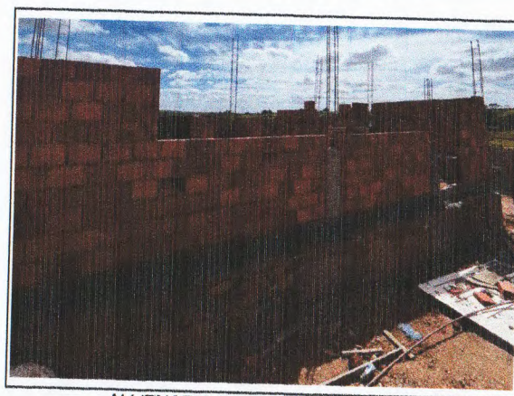
ALVENARIA DE BLOCO CERÂMICO
