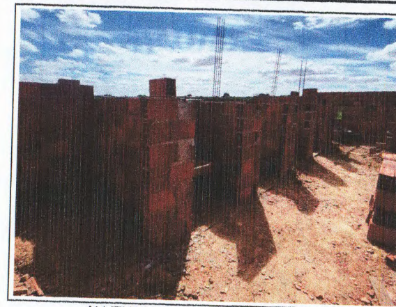
ALVENARIA DE BLOCO CERÂMICO
