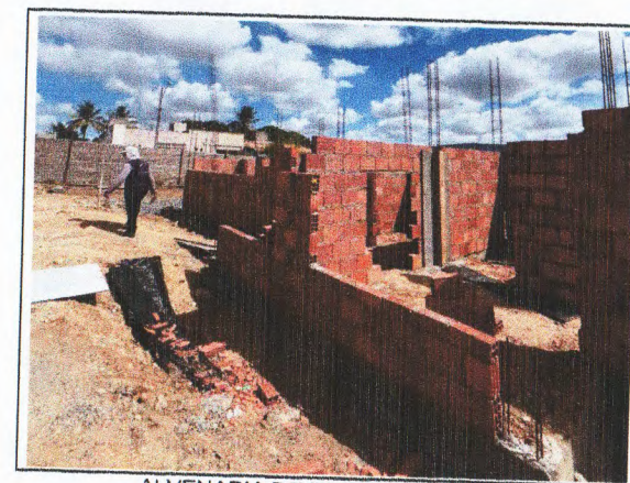
ALVENARIA DE BLOCO CERÂMICO
