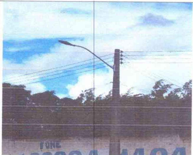
RUA PARALELA A BR-235 – TRECHO 02
