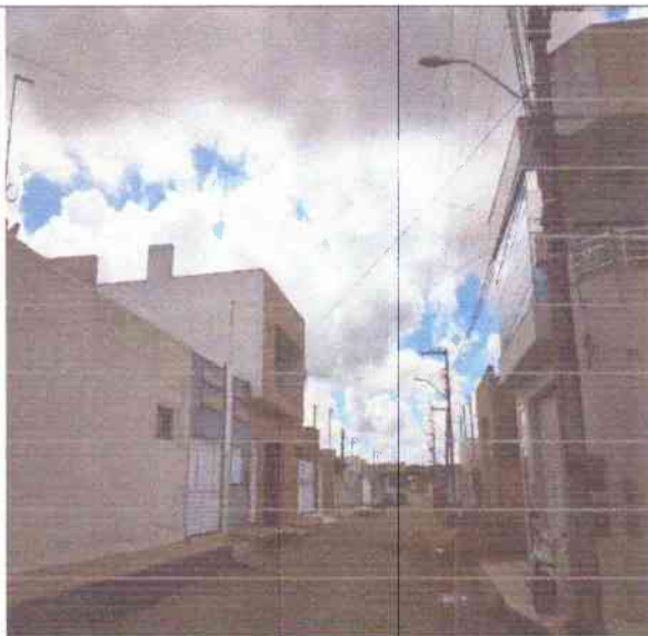
RUA JOSEFA SANTANA MONTEIRO – LOTEAMENTO PARAISO DA SERRA
