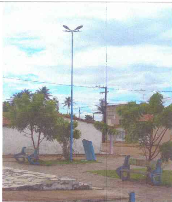
PRAÇA DO POVOADO MANGUEIRA
