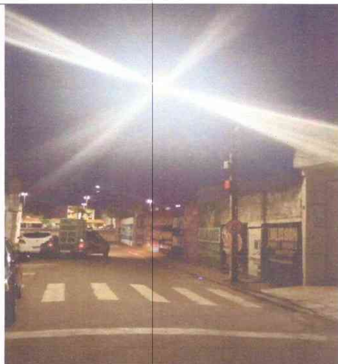
RUA SANTA CRUZ – TRECHO 01 + TRECHO 02
