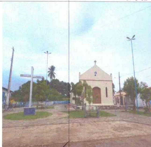
PRAÇA DO POVOADO MANGUEIRA
