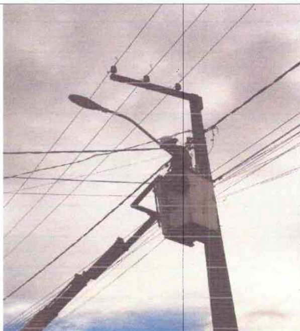
RUA JOSEFA SANTANA MONTEIRO – LOTEAMENTO PARAISO DA SERRA
