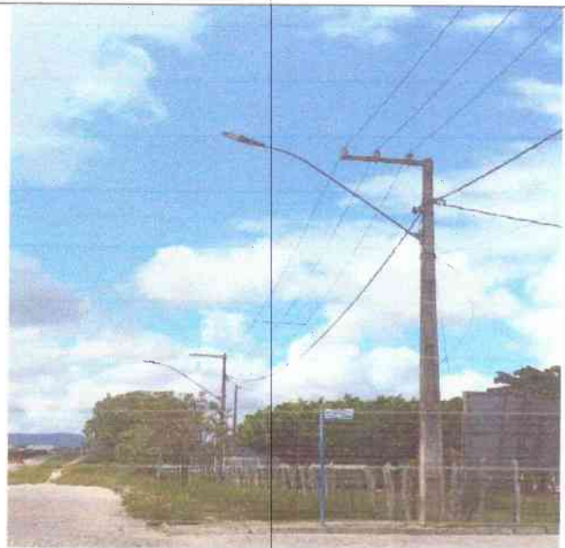
RUA PARALELA A BR-235 – TRECHO 01
