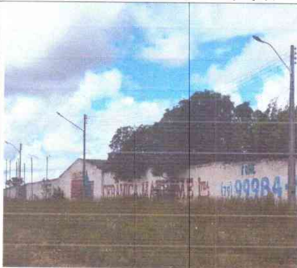
RUA PARALELA A BR-235 – TRECHO 02
