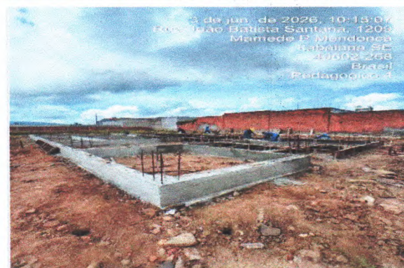
MONTAGEM E DESMONTAGEM DE FÔRMA (Coordenadas, comentários, etc.)
