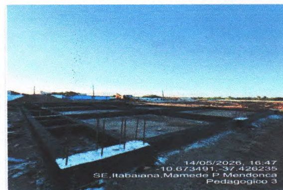
CONCRETAGEM DE VIGA BALDRAME (Coordenadas, comentários, etc.)
