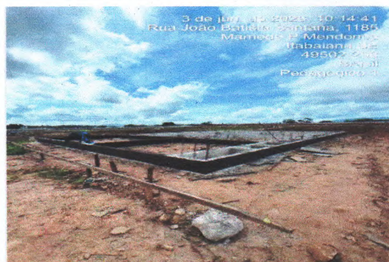
CONCRETAGEM DE VIGA BALDRAME (Coordenadas, comentários, etc.)
