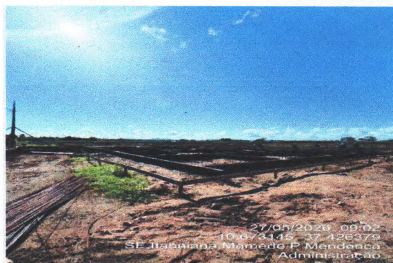
CONCRETAGEM DE VIGA BALDRAME (Coordenadas, comentários, etc.)
