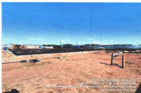
CONCRETAGEM DE VIGA BALDRAME (Coordenadas, comentários, etc.)
