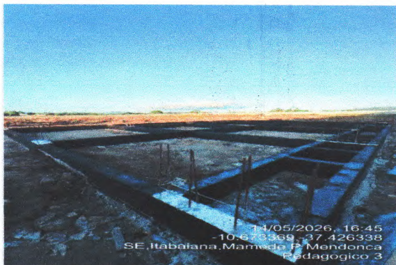
CONCRETAGEM DE VIGA BALDRAME (Coordenadas, comentários, etc.)
