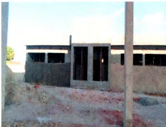
ALVENARIA DE BLOCO CERÂMICO; CHAPISCO; REBOCO
