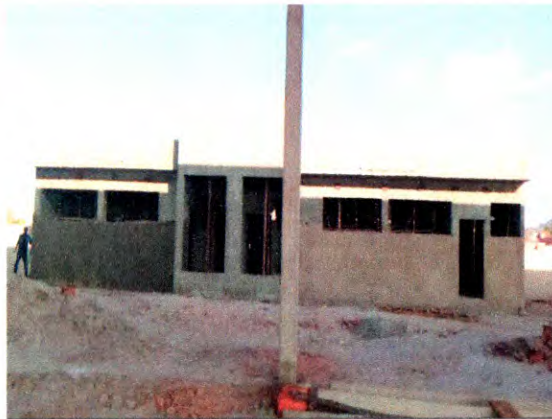
ALVENARIA DE BLOCO CERÂMICO; CHAPISCO; REBOCO
