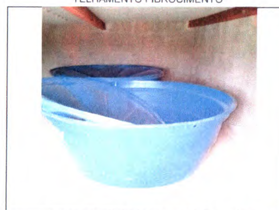
CAIXAS D'ÁGUA EM POLIETILENO 1.000L
