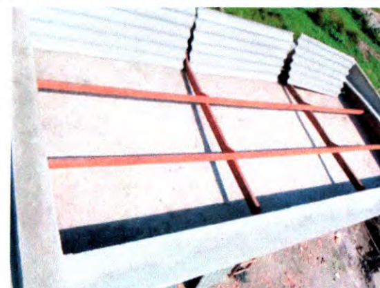
RUFO DE CONCRETO; PEÇAS DE MADEIRA; TELHAMENTO FIBROCIMENTO
