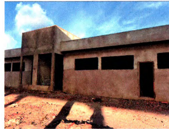
ALVENARIA DE BLOCO CERÂMICO; CHAPISCO; REBOCO
