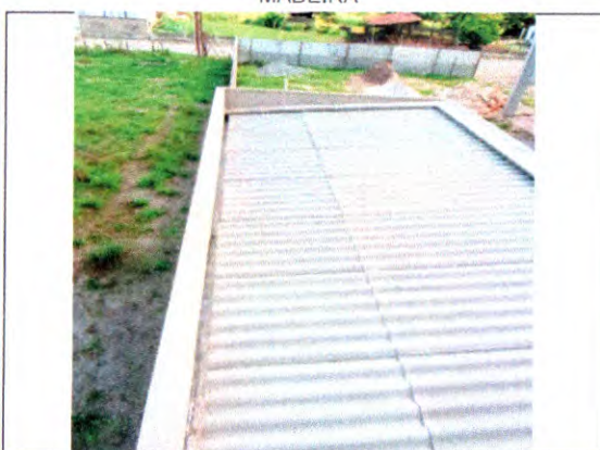
CALHA EM ALUMÍNIO; RUFO DE CONCRETO; TELHAMENTO FIBROCIMENTO
