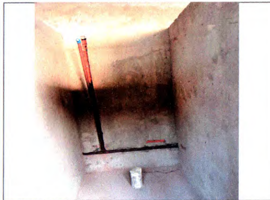
ALVENARIA DE BLOCO CERÂMICO; CHAPISCO; REBOCO; TUBULAÇÃO ÁGUA FRIA E ESGOTO
