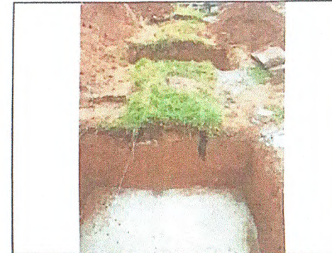
ESCAVAÇÃO MANUAL DE VALA, CONCRETO MAGRO
