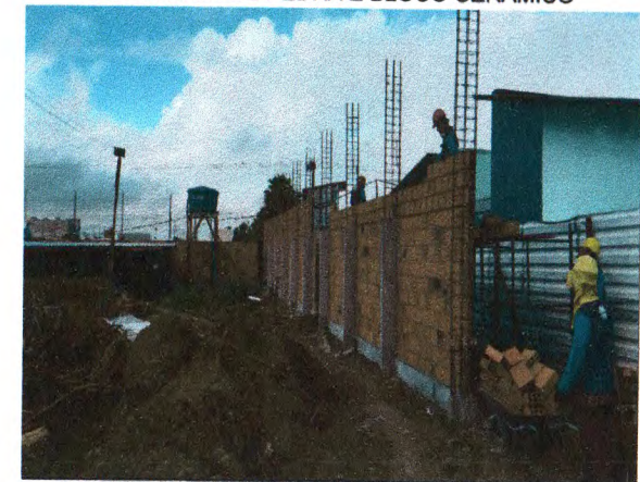
CONCRETO ARMADO PILARES E CINTA INFERIOR; ALVENARIA DE PEDRA ARGAMASSADA E BLOCO CERÂMICO; TAPUME METÁLICO
