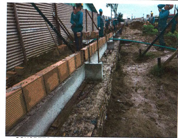
CONCRETO ARMADO PILARES E CINTA INFERIOR; ALVENARIA DE PEDRA E BLOCO CERÂMICO
