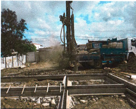
EXECUÇÃO DO ABRIGO DOS RESERVATÓRIOS PARA IRRIGAÇÃO; PERFURAÇÃO DO POÇO ARTESIANO
