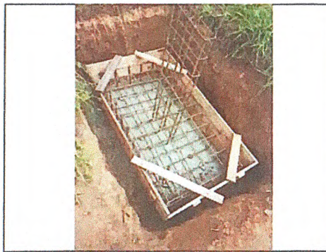
ESCAVAÇÃO MANUAL DE VALA, CONCRETO MAGRO; FORMA DE MADEIRA PARA FUNDAÇÃO; FERRAGEM DA SAPATA E ARRANQUE DO PILAR
