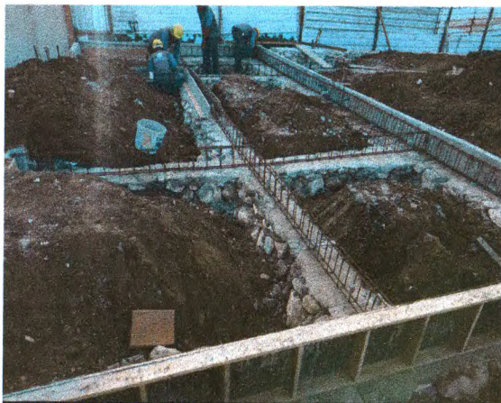
EXECUÇÃO DO ABRIGO DOS RESERVATÓRIOS PARA IRRIGAÇÃO
