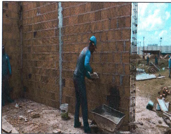
EXECUÇÃO DO ABRIGO DOS RESERVATÓRIOS PARA IRRIGAÇÃO
